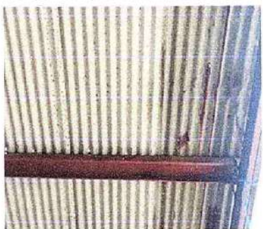
Foto 1: 1. Cierta de lámina. 1.1 Sustitución de lámina, por lámina troquelada aluzinc 26
