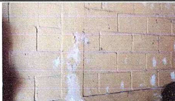
Foto 16: 21. Reparación de repello y cernido de paredes 21.1 Repello en muro
