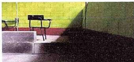
Foto 12: 15. Muros perimetrales 15.1 Reparación de muro perimetral de block
