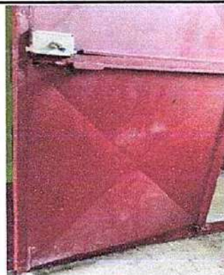
Foto 13: 19. Mano de obra especializada (albañilería, herrería y electricidad) 19.3 Fabricación e instalación de puertas de metal en módulos
