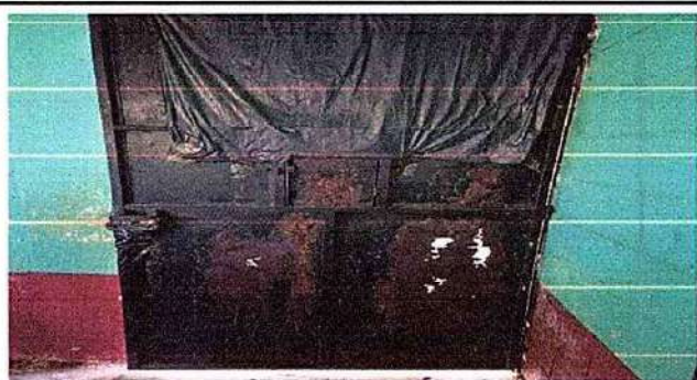
Foto 3: PUERTAS DE METAL 4.3 sustitución de puertas
