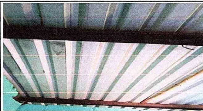
Foto 2: ESTRUCTURA DE TECHO 2.2. Sustitución de estructura de soporte de madera por metal
