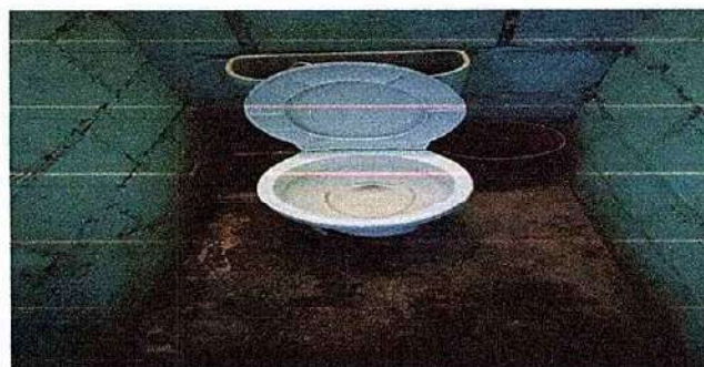
Foto 2: SERVICIOS SANITARIOS 10.3 SUSTITUCIÓN DE INODOROS
