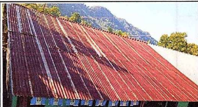
Foto 1: CUBIERTA DE LAMINA 1.1 Sustitución de lámina, por lámina troquelada aluzinc calibre 26 1.2 Sustitución de capote de lámina para lámina troquelada 1.3 sustitución de elementos de fijación
