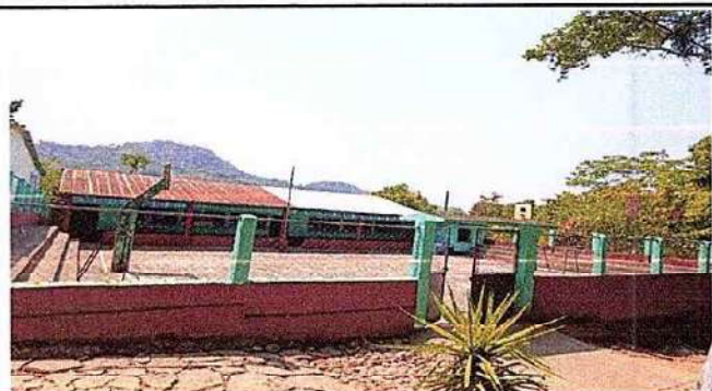
Foto1: PINTURA EN MUROS INTERIORES E EXTERIORES 9.1 Pintura en muros interiores e exteriores
