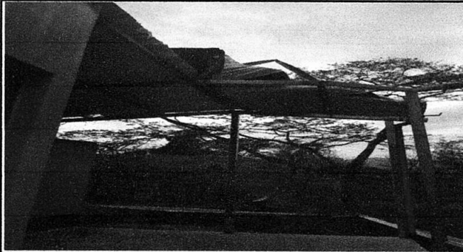
Foto 1: Foto 1: CUBIERTA DE LAMINA 1.1 Sustitución de lamina por lamina troquelada aluzic calibre 26. 1.2 Sustitución de elementos de fijación.
