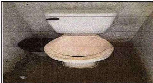
Foto 8: SERVICIOS SANITARIOS Y SUS ACCESORIOS 10.2 Sustitución inodoro.
