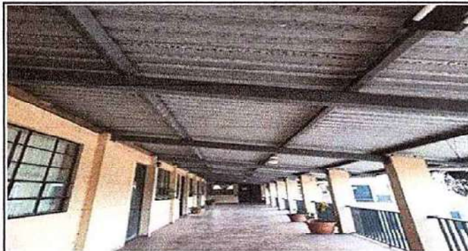
Foto 2: ESTRUCTURA DE TECHO 2.1 Mantenimiento a estructura de soporte de metal
