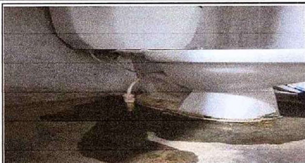
Foto 7: SERVICIOS SANITARIOS Y SUS ACCESORIOS 10.2 Sustitución de accesorios inodoro (contra llave, tubo de abasto y tanque).
