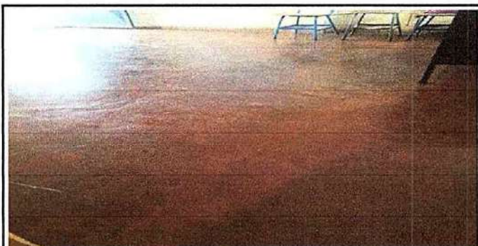
Foto 5: PISO 6.5 Sustitución de piso de torta de concreto
