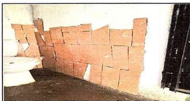
Foto 11: SUSTITUCIÓN DE AZULEJO 13.1 Sustitución de Azulejo.
