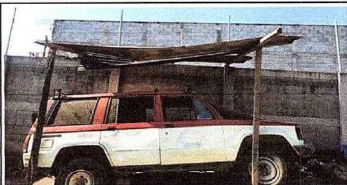
FOTO 1. CUBIERTA DE LAMINA: 1.1 Sustitución de lámina, por lámina troquelada aluzinc calibre 26
