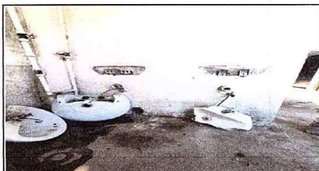
Foto 9: SERVICIOS SANITARIOS Y SUS ACCESORIOS 10.5 Sustitución lavamanos.
