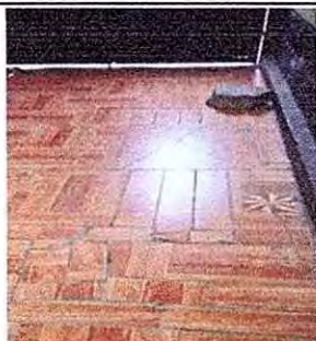
Foto 4: 6 PISO 6.8 Sustitución de piso cerámico
