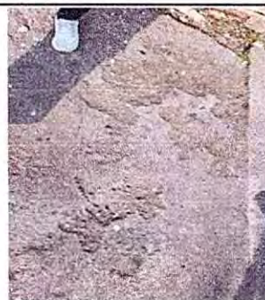
Foto 4: 6 PISO 6.1 Reparación de piso de torta de concreto
