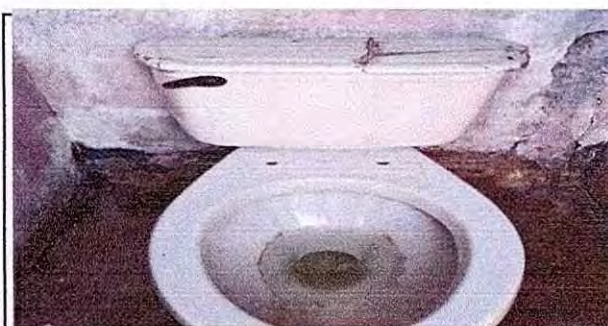
Foto 9: 10 SERVICIOS SANITARIOS Y SUS ACCESORIOS 10.3 Sustitución inodoro
