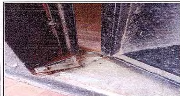
Foto 10: 12 MANTENIMIENTO A PORTONES 12.1 Mantenimiento a portones de metal
