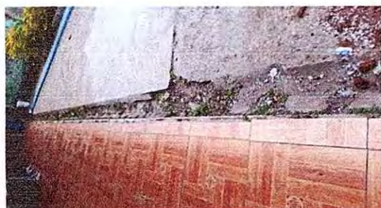
Foto 6: 8 CUNETA DE CONCRETO 8.1 Reparación de cuneta de concreto
