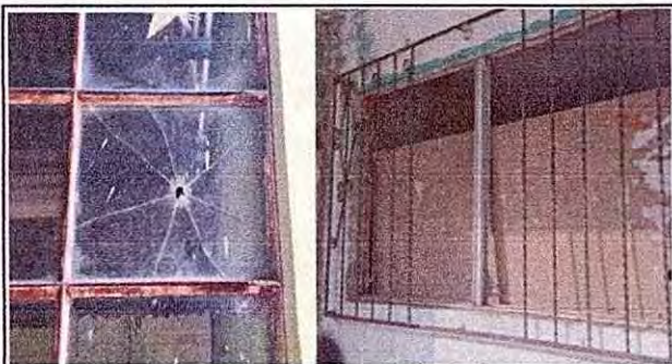
Foto 3: 5 VENTANAS 5.5 Sustitución de vidrios 5.6 Sustitución de balcones de metal
