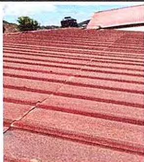
Foto 1: 1 CUBIERTA DE LAMINA 1.1 Sustitución de lámina, por lámina troquelada aluzinc calibre 26
