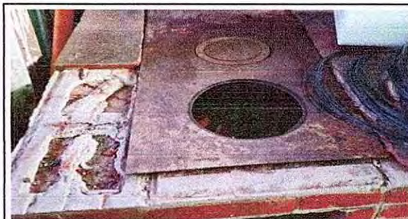
Foto 12: REPARACION DE COCINA 20.7 Instalación de azulejo en estufa rural
