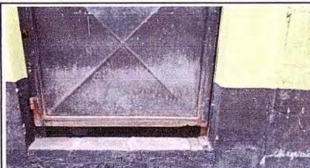
Foto 8: 10 SERVICIOS SANITARIOS Y SUS ACCESORIOS 10.1 Mantenimiento a estructura (lijado, cambio de tubo, cepillado, sujeciones, aplicación de pintura) a puertas servicios sanitarios
