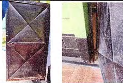
Foto 2: 4 PUERTAS DE METAL 4.1 Mantenimiento a estructura (lijado, cambio de tubo, cepillado, sujeciones, aplicación de pintura) 4.3 Sustitución de puerta
