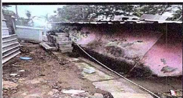
Foto 7. Pintura en muros exteriores. Área de salón de Preprimaria
