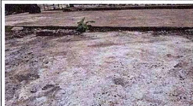
Foto 9. Reparación de Plancha de Concreto de Patio: área de patio de frente de la escuela
