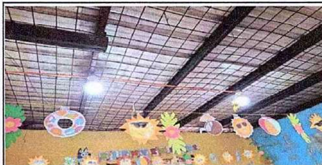
Foto 4: sustitución de estructura de soporte de metal por metal. Área de Preprimaria
