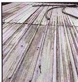
Foto1: Sustitución de lámina, por lámina troquelada aluzinc calibre 26, área de preprimaria y Primaria
