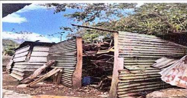
Foto 3: Sustitución de estructura de soporte de madera, por metal. Área de bodega 2.
