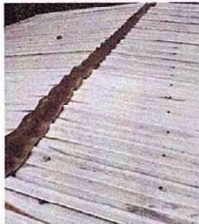
Foto1: Sustitución de lámina, por lámina troquelada aluzinc calibre 26, área de preprimaria y Primaria
