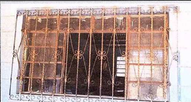
Foto 16: Sustrucción de estructura de metal de ventana, salón cuarto y quinto.
