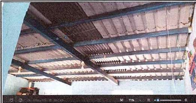
Foto 7: Mantenimiento a estructura de soporte de metal, salón de cuarto y quinto.
