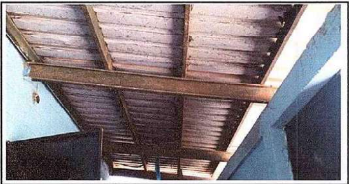
Foto 5: Mantenimiento a estructura de soporte de metal, corredor.
