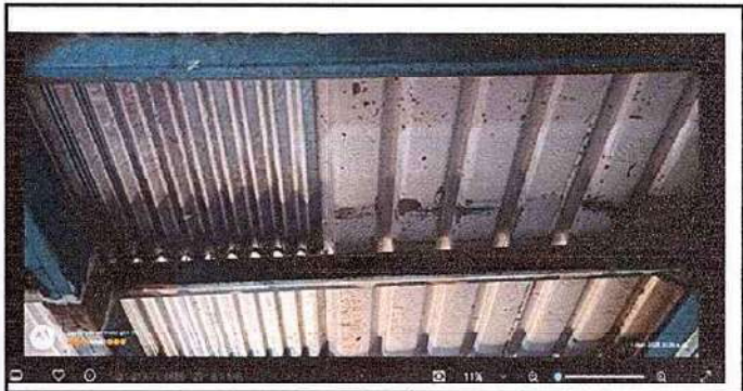
Foto 6: Matenimiento a estructura de soporte de metal, salón de prepa.
