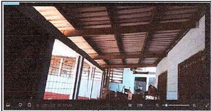
Foto 4: Sustitución de lamina, corredor
