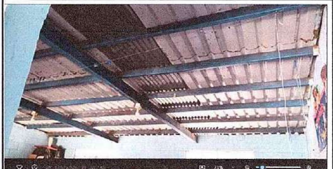
Foto 2: Sustitución de lámina, salón de cuarto y quinto
