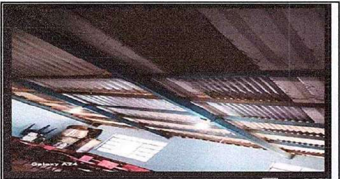
Foto 3: Sustitución de lámina, salón segundo y tercero
