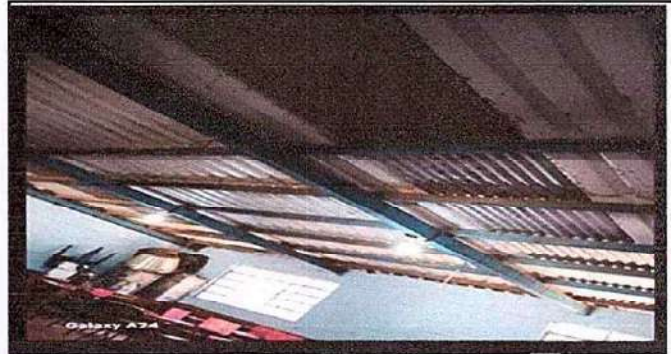
Foto 8: Mantenimiento a estructura de soporte de metal, salón segundo y tercero.
