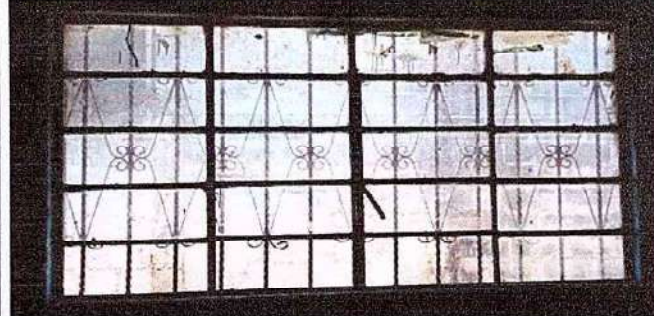
Foto 14: Sustrucción de estructura de metal de ventana, salón de segundo y tercero.
