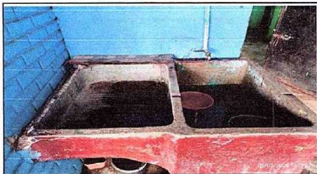
Foto 9: Sustrucción de llave de chorro. Área de corredor
