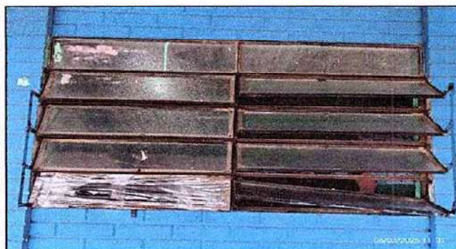
Foto 3: Mantenimiento a estructura de metal de ventana, Sustitución de vidrios. Grados de tercero y cuarto.
