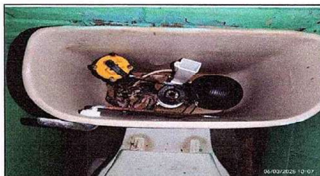
Foto 4: Sustitución de accesorios de inodoro (contra llave, tubo de absto y tanque) área de sanitarios.
