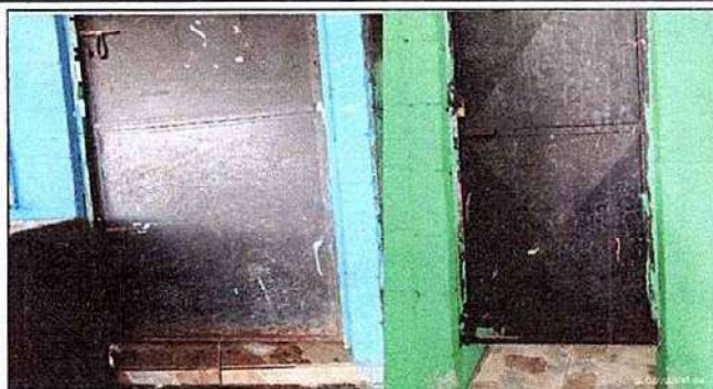
Foto 1: Mantenimiento a estructura (lijado, cambio de tubo, cepillado, sujeciones, aplicación de pintura) área de baños
