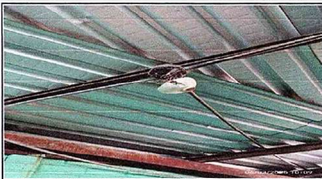
Foto 8: Sustrucción de flipones, Reparación de cableado Electric, área de sanitarios y cocina.
