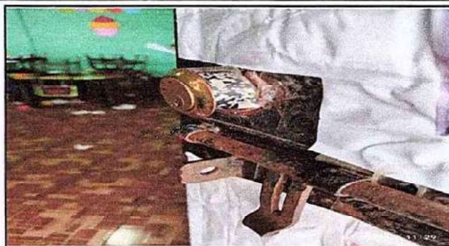
Foto 2: Sustitución de chapas, grado de preprimaria.
