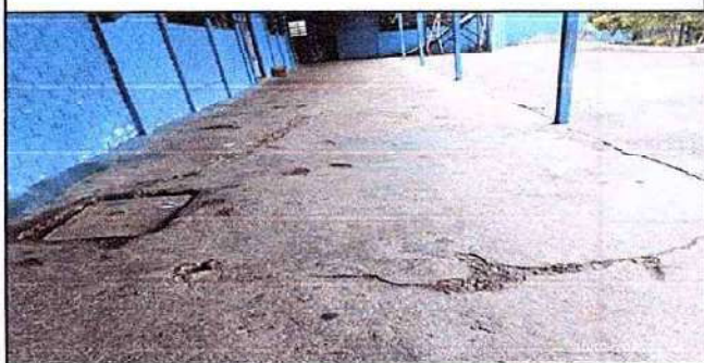
Foto 7: Sustrucción de piso de torta de concreto, área de corredor.
