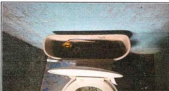
Foto 10: Sustitución de accesorios inodoro (contra llave, tubo de abasto y tanque).
