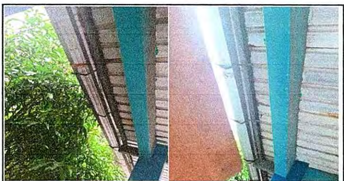
Foto 6: Sustrucción de soporte o pescante de metal para canal
