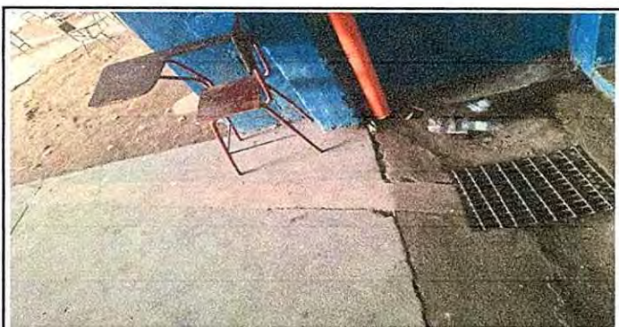
Foto 12: Sustitución de tubería PVC línea principal aguas pluviales.
