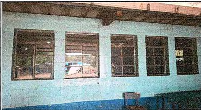
Foto 3: Sustrucción de estructura de metal de ventana
