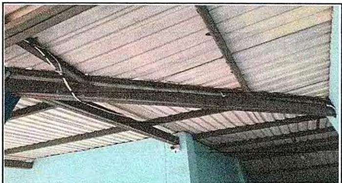
Foto 4: Sustrucción de canal de metal
