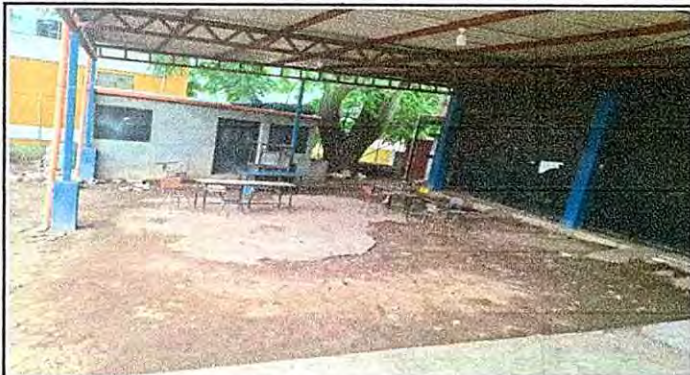
Foto 13: Reparación de planchas de concreto de patio.
