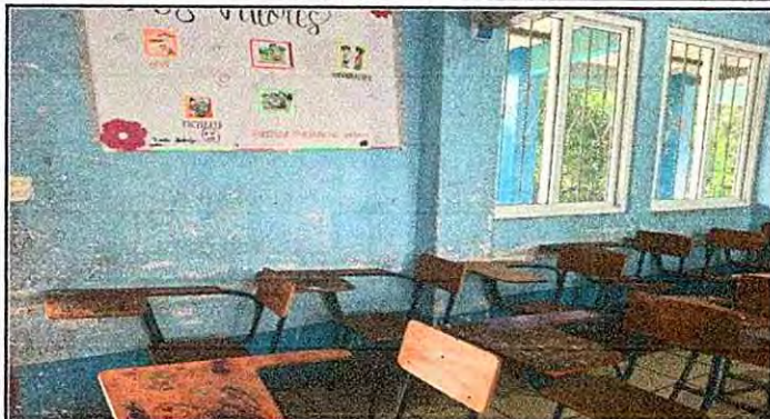
Foto 7: Pintura en muros exteriores e interiores
