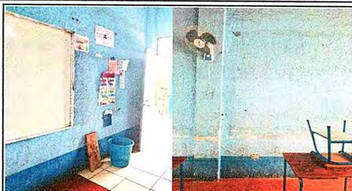
Foto 8: Pintura en muros exteriores e interiores
