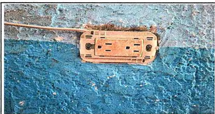
Foto 17: Sustitución de tomacorrientes dobles.
