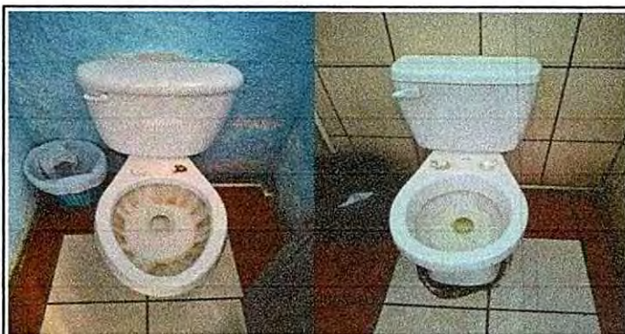
Foto 11: Sustitución de tapadera sanitario
