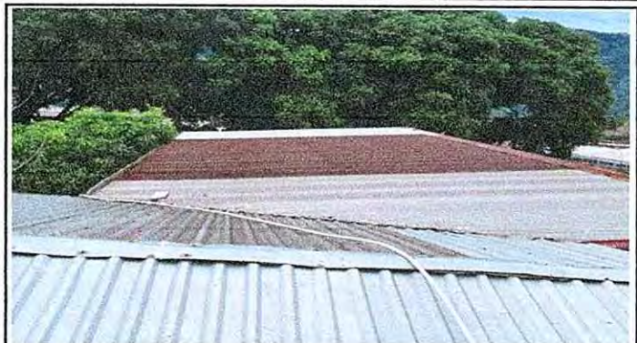
Foto 2: Sustrucción de lamina, por lamina troquelada aluzinc calibre 26
