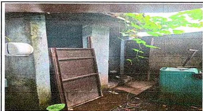
Foto 9: Mantenimiento a estructura (lijado, cambio de tubo, cepillado, sujeciones, aplicación de pintura) a puertas servicios sanitarios.
