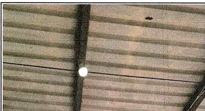
Foto 15: Sustitución de plafoneras.
