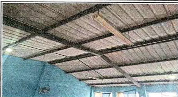
Foto 14: Sustitución de focos ahorradores
