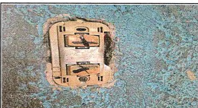
Foto 16: Sustitución interruptores dobles.
