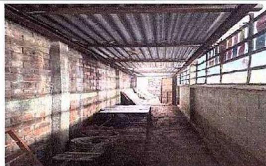
Foto 18: Repello en muro
