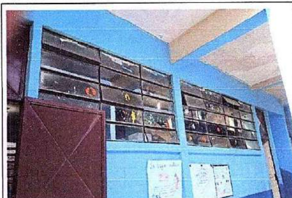
Foto 8: Mantenimiento a estructura de metal de ventana.
