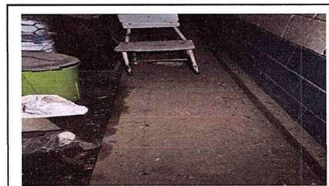
Foto 11: Reparación de piso de torta de concreto
