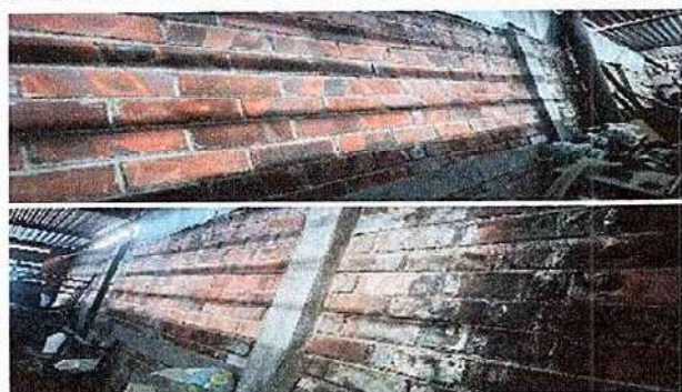
Foto 19: Repello en muro.
