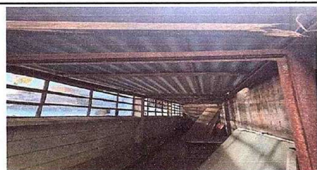
Foto 3: Sustitución de lámina, por lámina troquelada aluzin calibre 26, área bodega No 2.
