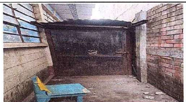
Foto 5: Mantenimiento de estructura (lijado, cambio de tubo, cepillado, sujeciones, aplicación de pintura)
