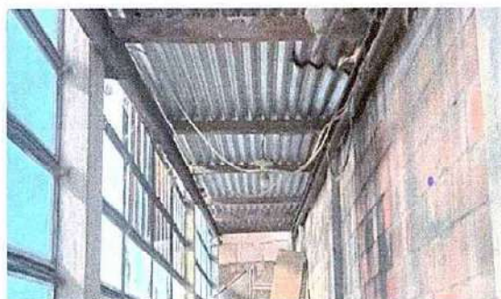
Foto 20: Reparación de cableado eléctrico
