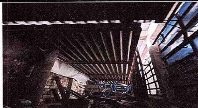
Foto 2: Sustitución de lámina, por lámina troquelada aluzin calibre 26, área bodega No 1.
