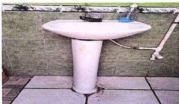
Foto 15: Sustrucción de lavamanos.
