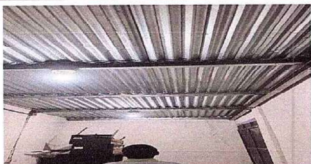
Foto1: Sustitución de lámina, por lámina troquelada aluzin calibre 26, área de cocina.
