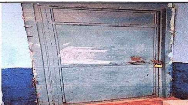
Foto 6: Sustitución de chapa.
