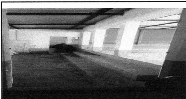
Foto 15: Sustitución de piso de concreto por piso cerámico. Área corredor sanitarios
