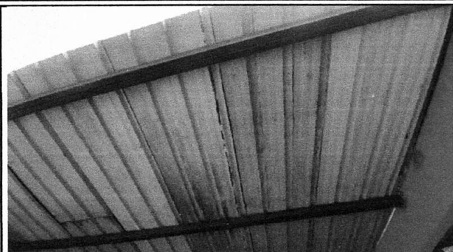
Foto1: Sustrucción de lámina, por lámina troquelada aluzinc calibre 26. Área de entrada
