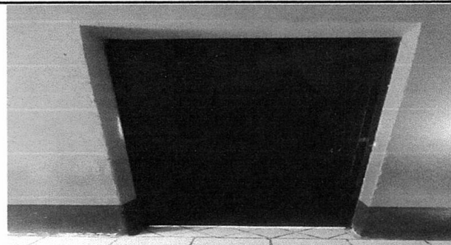
Foto 8: Sustitución de chapa. Módulo 3
