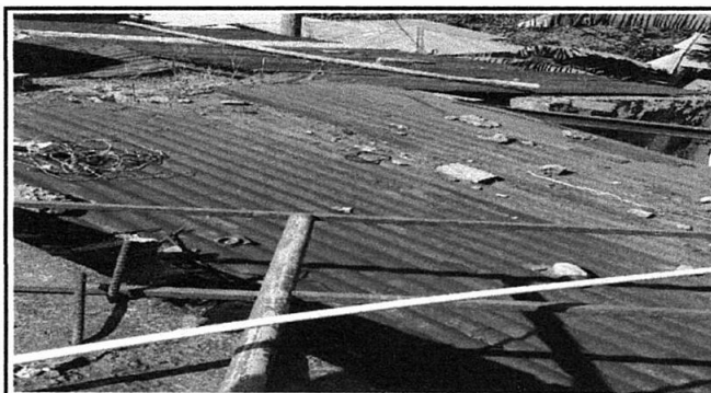
Foto 4: Sustrucción de lámina, por lámina troquelada aluzinc calibre 26. Módulo 5
