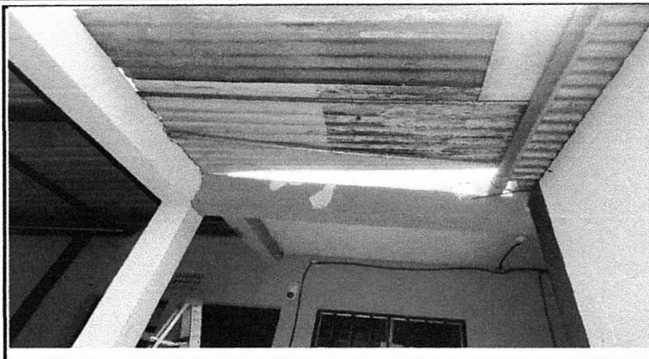
Foto 2: Sustrucción de lámina, por lámina troquelada aluzinc calibre 26. Área juegos.
