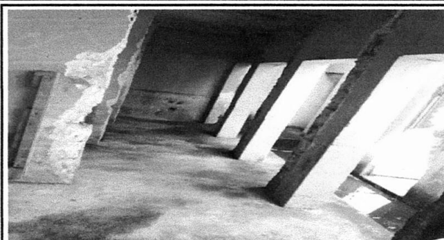
Foto 20: Reparación de columnas.
