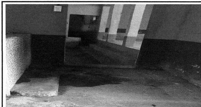
Foto 17: Sustitución de azulejo area pila
