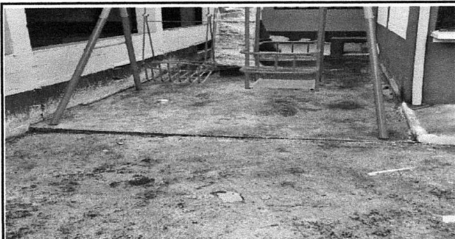
Foto 13: Sustitución de piso de concreto por piso cerámico. Área juegos
