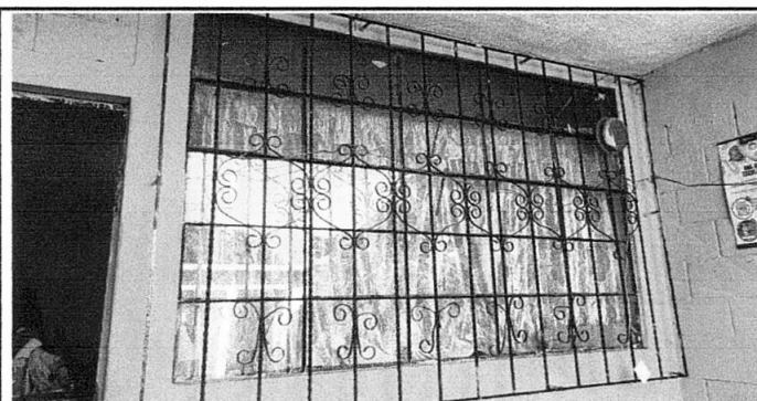
Foto 5: Sustitución de ventanas en el salón de tercero primaria "B"
