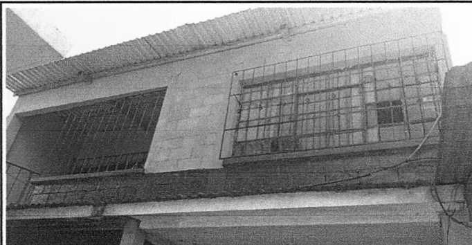
Foto 2: Sustitución de ventana del salón de clases de Sexto Primaria "A"
