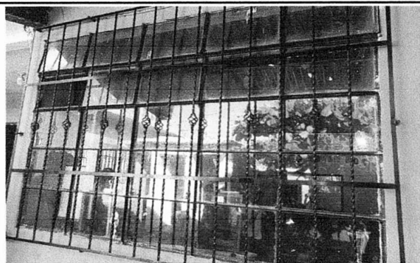
Foto 8: Sustitución de ventana del salón de Tercero primaria "A"
