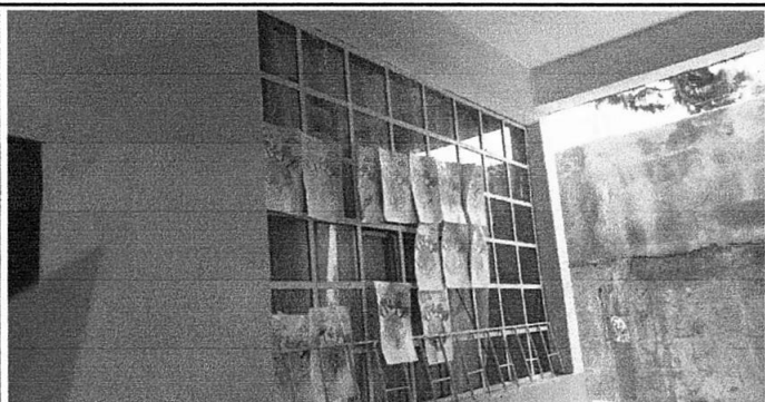
Foto 7: Instalación de ventanas de párvulos 4 y 5.
