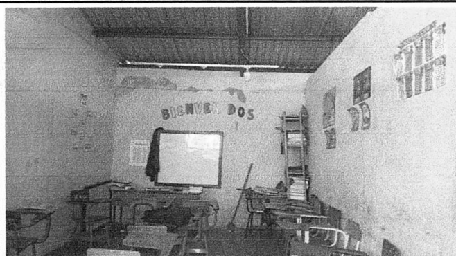
Foto 27: Reconstrucción de cernido de pared 1 en el salón de tercero primaria "A"
