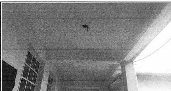
Foto 22: Instalación de bombillos en el corredor.
