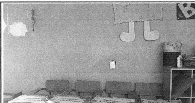
Foto 24: Instalación de tomacorriente en el salón de Párvulos
