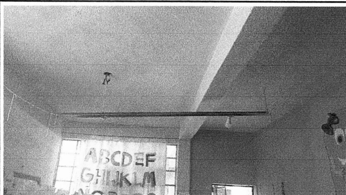
Foto 19: Instalación de lámparas en el salón de Párvulos 6.
