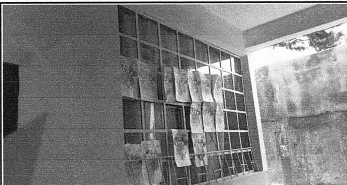
Foto 10: Instalación de balcones del salón de Párvulos 4 y 5.
