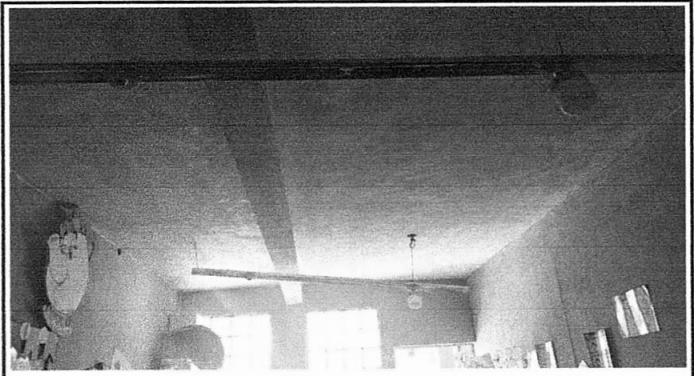
Foto 14: Instalación de lámparas en el salón de párvulos 4 y 5.
