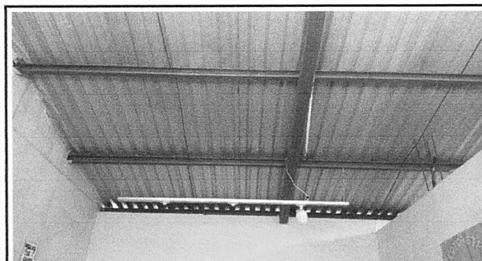
Foto 17: Instalación de bombillos.
