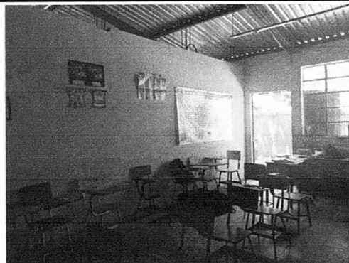
Foto 28: Reconstrucción de cernido de pared 2 en el salón de tercero primaria "A"
