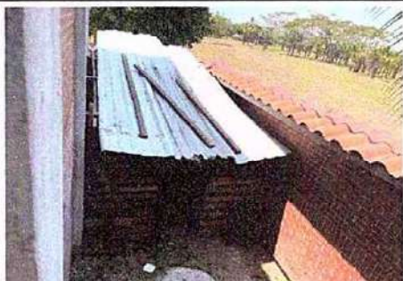
Foto1: 1.1 Sustitución de lámina por lámina troquelada aluzinc calibre 26
