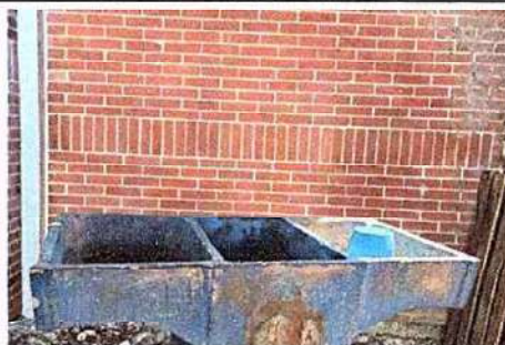
Foto 4: 20.10 Sustitución de pila de cemento de 2 lavaderos
