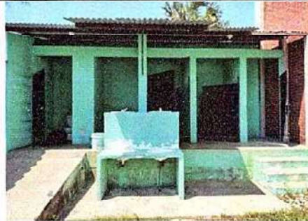
Foto 7: 19.4 Fabricación e Instalación de puertas de metal en baños
