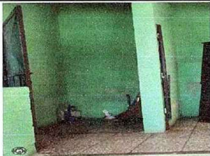
Foto 6: 13.1 Sustitución de azulejos
