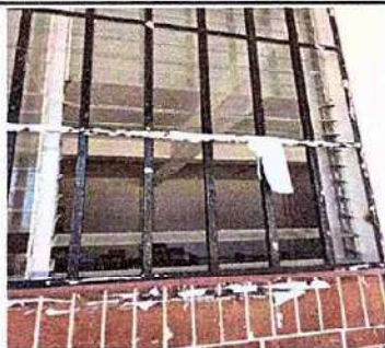
Foto 3: 5.7 Mantenimiento a balcones de metal
