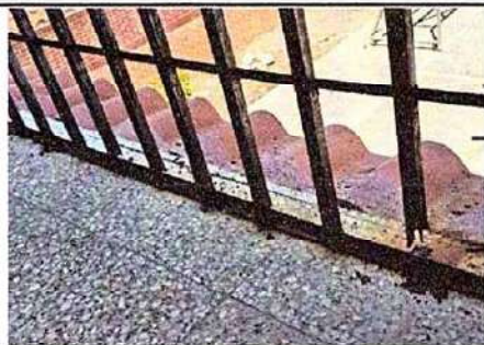
Foto 5: 11.2 Sustitución de barandas de metal
