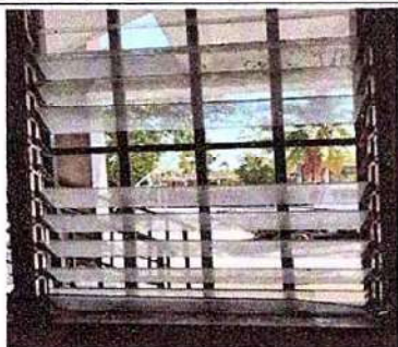
Foto 1: 5.4 Mantenimiento a marcos de aluminos mill finish
