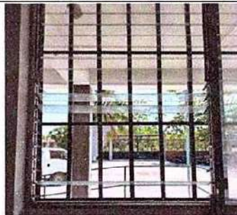
Foto 2: 5.5 Sustitución de vidrios
