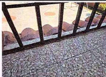
Foto 4: 11.1 Mantenimiento a barandas de metal
