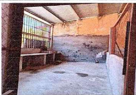
Foto 5: Region 9.1 (Pintura en muros exteriores e interiores)
