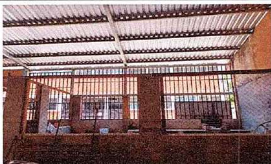
Foto 3: Region 5.2 (Sustitución de estructura de metal de ventana)
