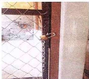
Foto 5: Region 4.2 (Sustitución de chapa)
