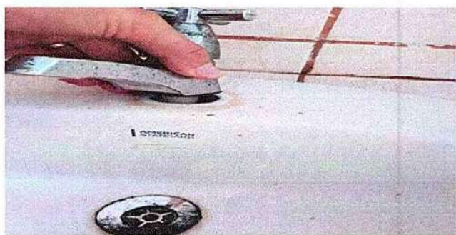
Foto 3: 10.4 Sustitucion de mezcladora lavamanos (contra llave,tubo de abasto)
