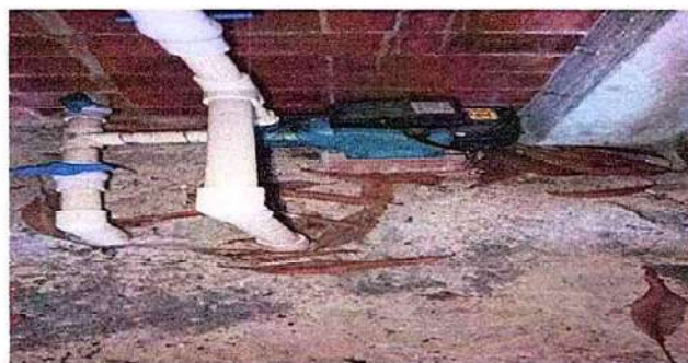
Foto 2: 18.7 Sustitucion de bomba de agua
