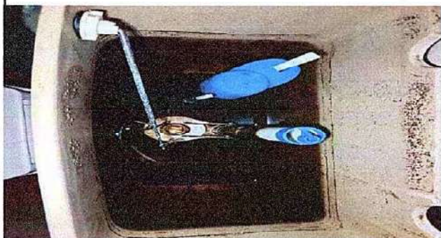
Foto1: 10.2 Sustitucion de accesorios inodoro (contra llave, tubo de abasto y tanque) sustitucion de tapadera sanitario
