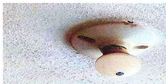
Foto 6: 17.3 Sustitucion de lamparas LED
