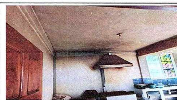
Foto 6: 9.1 Pintura en muros exteriores e interiores
