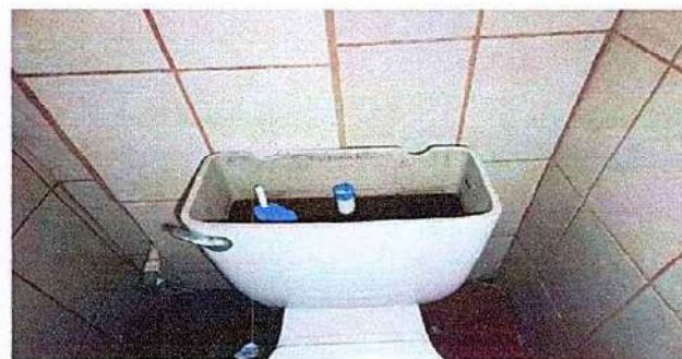
Foto 2: 10.3 sustitucion de inodoro
