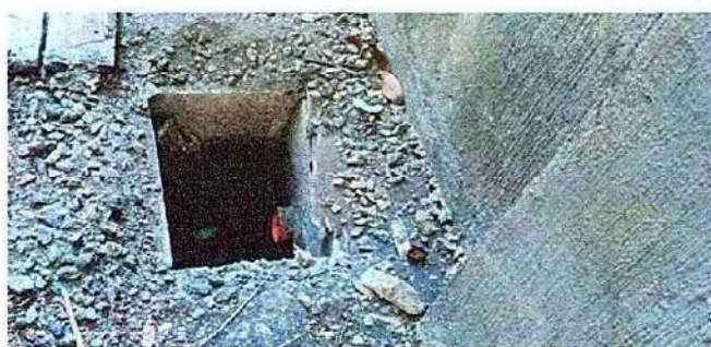
Foto 5: 14.8 Sustitucion de caja de registro
