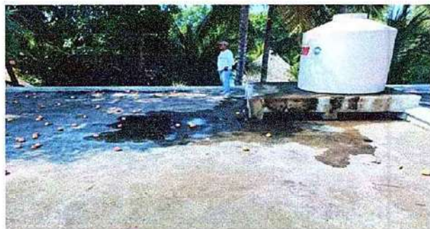
Foto 1: 3.1 Impermeabilización de losa
