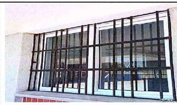
Foto 4: 5.7 Mantenimiento a balcones de metal
