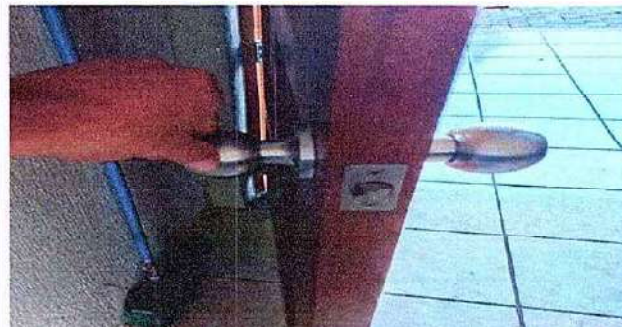
Foto 2: 4.2 Sustitución de chapa
