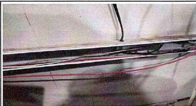
Foto1: 17.11 Reparacion de cableado electrico
