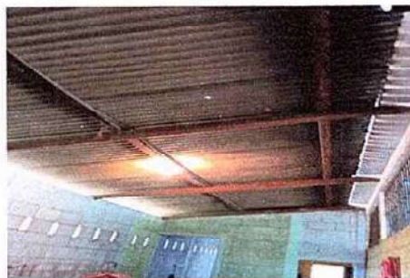
Foto 2: 1 CUBIERTA DE LAMINA. 1.1 Sustitución de lámina, por lámina troquelada aluzinc calibre 26" en el área de guardiania
