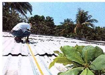
Foto 6: 19 MANO DE OBRA ESPECIALIZADA (ALBAÑILERIA, HERRERIA, ELECTRICIDAD Y PLOMERIA). 19.8 Instalación de lámina troquelada aluzinc
