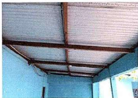
Foto1: 1 CUBIERTA DE LAMINA. 1.1 Sustitución de lámina, por lámina troquelada aluzinc calibre 26" en el área de baños
