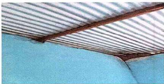
Foto 3: 2 ESTRUCTURA DE TECHO. 2.2 Sustitucion de estructura de soporte de madera, por metal en el área de baños
