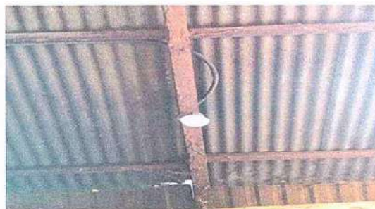
Foto 4: 2 ESTRUCTURA DE TECHO. 2.2 Sustitucion de estructura de soporte de madera, por metal en el área de guardiania
