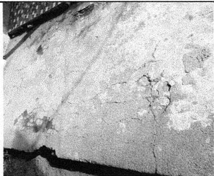
6. 8 Sustitucion de torta de concreto
