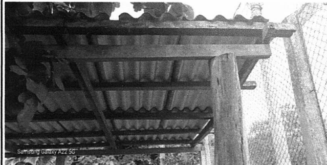
2. ESTRUCTURA DE TECHO
