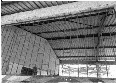
19.2 fabricacion e instalacion de balcones de hierro en ventana
