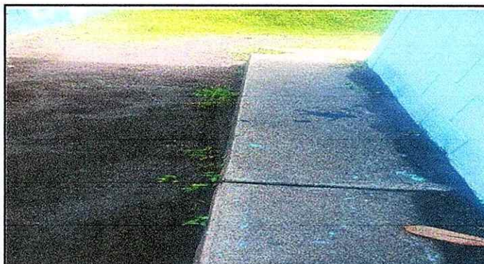
Foto 6.5 Susyiyución de torta de concreto
