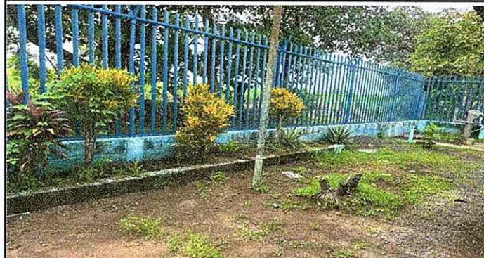
Foto 8: Reglón. 9.1. Pintura del muro perimetral
