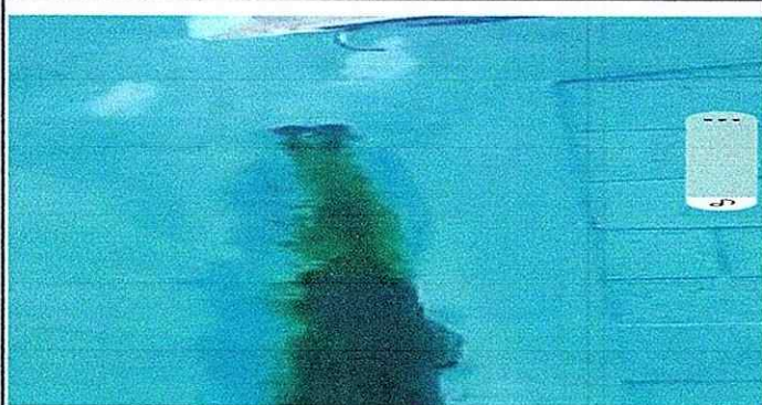
Foto 7: Reglón. 7.1., 7.3, 19.18 Cambios de tubería para evitar que siga deteriorando la pared.
