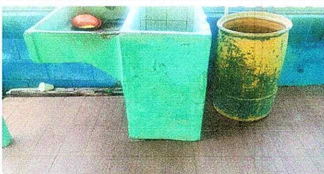
Foto 9: Renglón 19.20, 20.10 Sustitución de pila.
