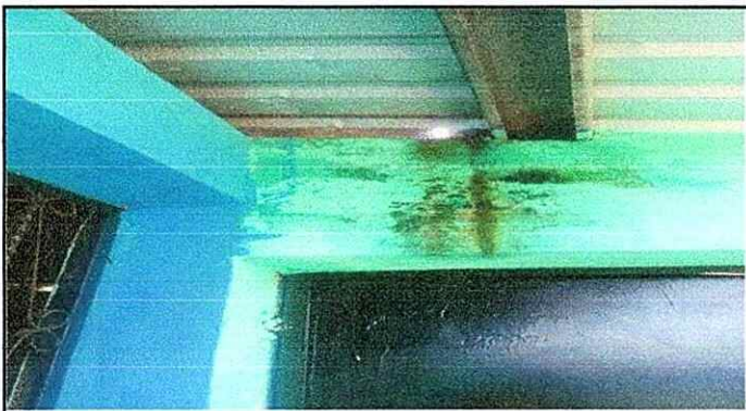
Foto 4: Mantenimiento del portón 4.5
