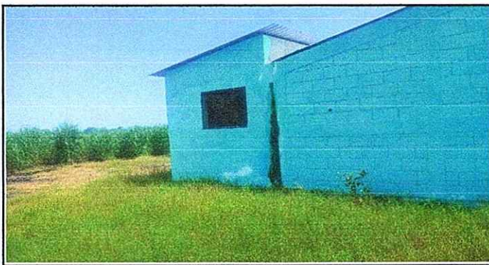
Foto 6: Donde cortan la malla y se anda arreglando constantemente
