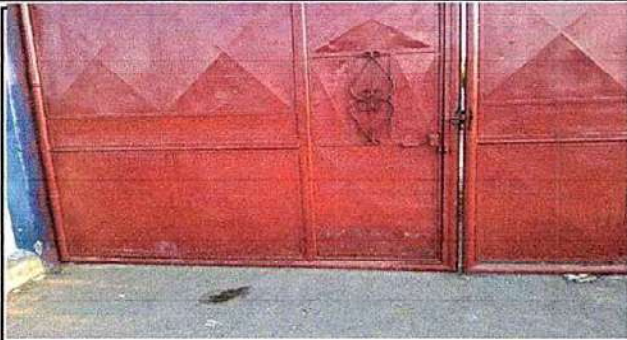
Foto7: 12.1 Mantenimiento a portones de metal
