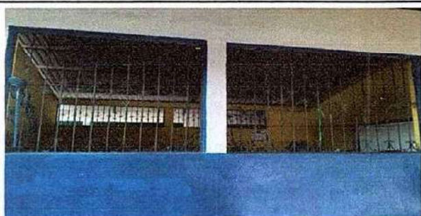
Foto 5: 5.7 Mantenimiento de balcones de metal
