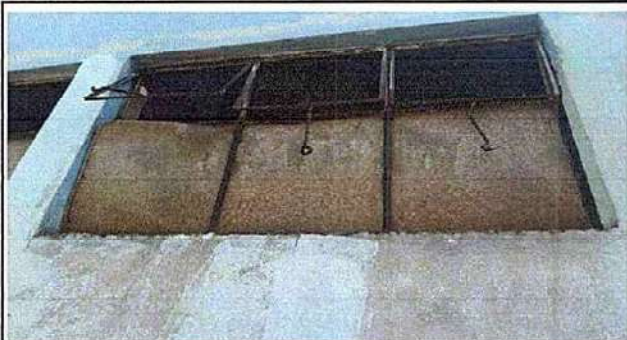
Foto 3: 5.3 Sustitución de ventanas de madera por metal mas vidrio
