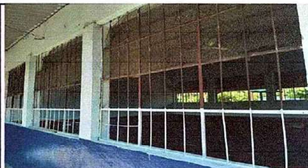
Foto 4: 5.6 Sustitución de Balcones de metal
