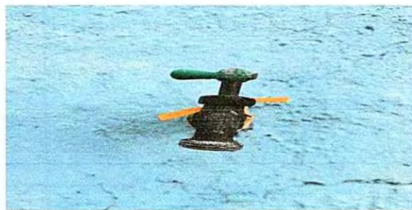
Foto 6: 14.13 Sustitución de llave de chorro
