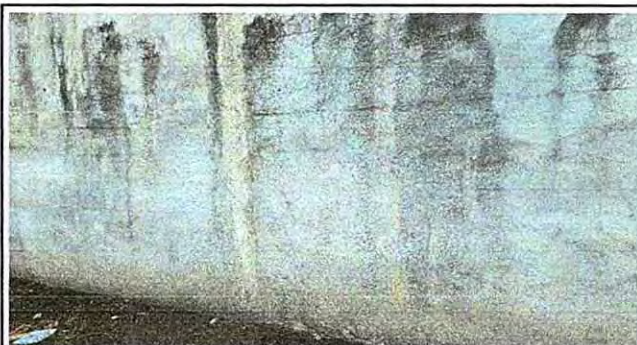
Foto 4: 9.1 PINTURA EN MUROS EXTERIORES E INTERIORES
