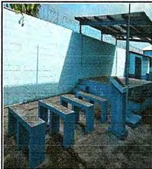
Foto1: 1. CUBIERTA DE LÁMINA
