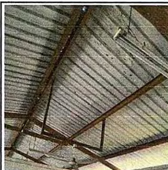
Foto 2: 2. ESTRUCTURA DE TECHO
