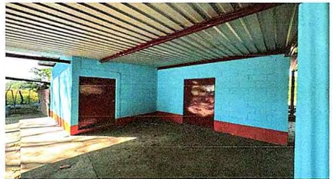
16.0 LOSA DE PISO 16.1 Reparación de planchas de concreto de patio
