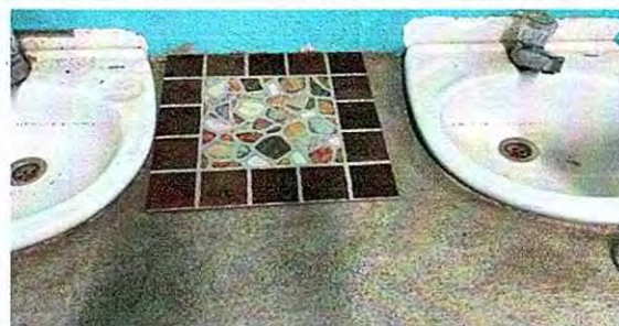
reglon 13.1: Sustitucion de Azulejo
