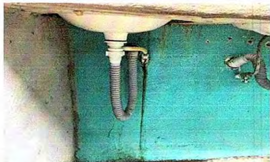
reglon 10.4 :Sustitución de mezcladora lavamanos (contra llave, tubo de abasto)
