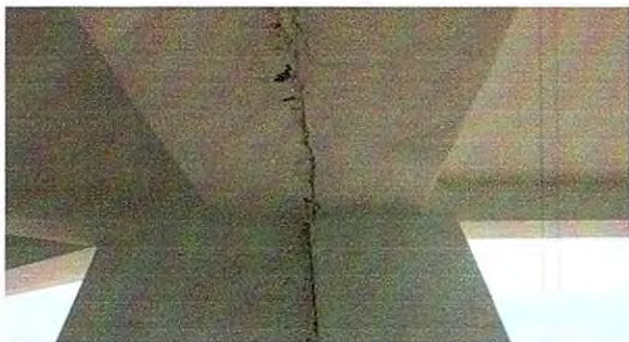
REGLON 3 : IMPERMEABILIZACION DE LOZA
