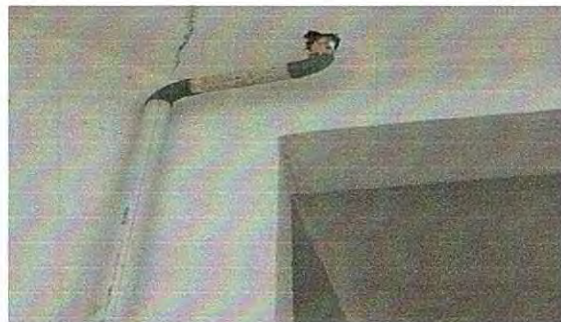
reglon 7.3 reparacion bajada de agua pluvial de metal por tubo PVC 3"
