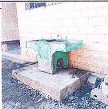
Foto 15 sustitución de pila de cemento de dos lavaderos 20.1
