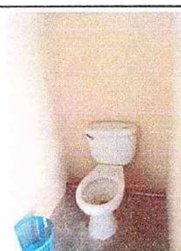
Foto 10: sustitución de inodoro 10.3
