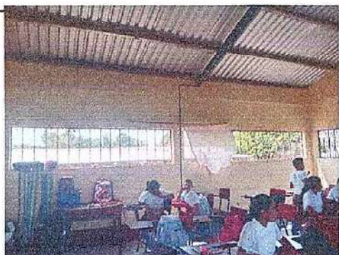
Foto 17: sustitución de estructura de metal de ventana 5.2
