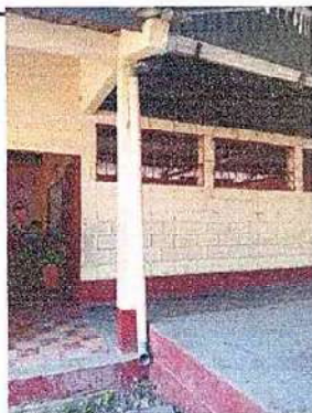
Foto 9 reparación de bajada de agua pluvial tubo pvc 3"
