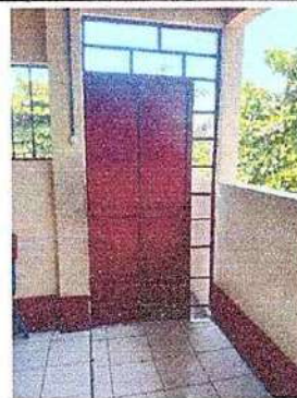
Foto 4: sustitución de puerta 4.3
