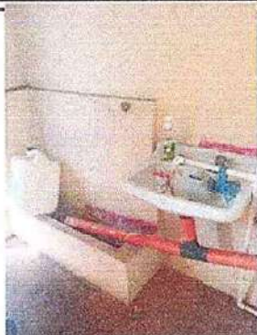
Foto 13 sustitución de mingitorio 10.8
