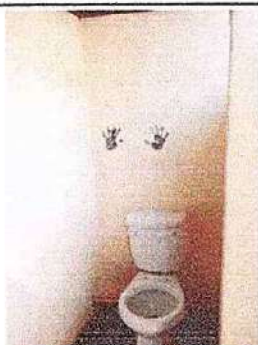
Foto 11: sustitución de inodoro 10.3
