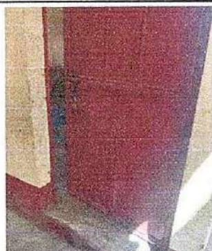
Foto 3: sustitución de puerta 4.3
