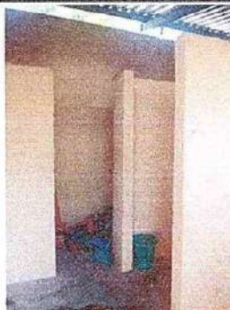
Foto 14 fabricación e instalación de puertas de metal en baños 19.4
