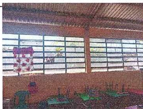
Foto 18: Sustitución de valcones de metal 5.6
