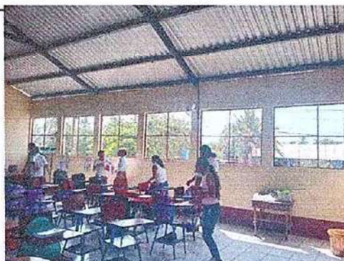
Foto 16: sustitución de estructura de metal de ventana 5.2
