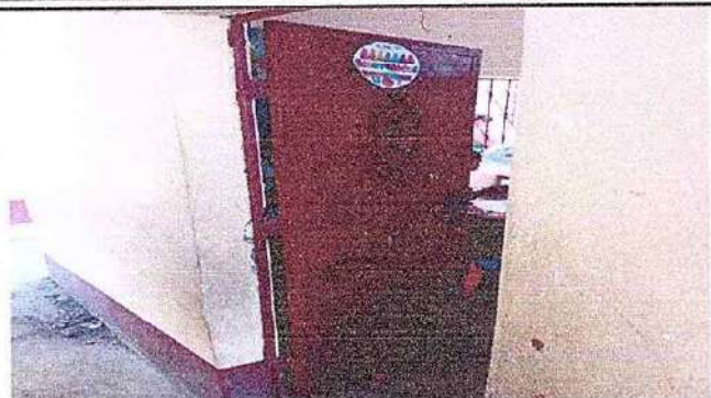
Foto1: Sustitución de puerta 4.3
