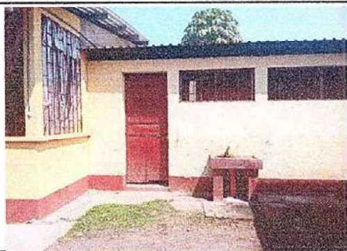
Foto 5: sustitución de puerta 4.3
