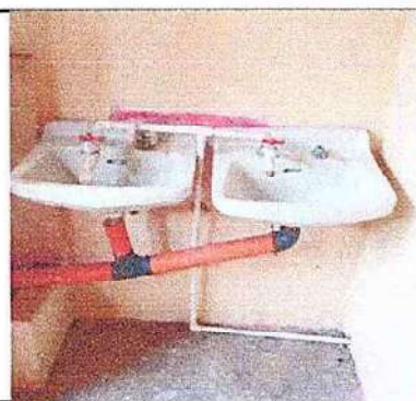
Foto 12: Sustitución de lavamanos 10.5
