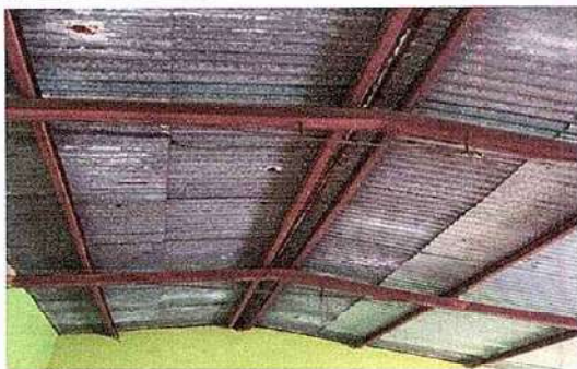
Foto1: 1 CUBIERTA DE LAMINA. 1.1 Sustitución de lámina, por lámina troquelada aluzinc calibre 26".
