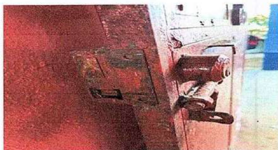
Foto 3: 4 PUERTAS DE METAL: 4.2 Sustitución de chapa
