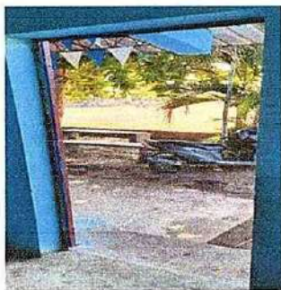
Foto 7: 19 MANO DE OBRA ESPECIALIZADA (ALBAÑILERIA, HERRERIA, ELECTRICIDAD Y PLOMERIA) 19.6 Fabricación e instalación de puerta de rejas
