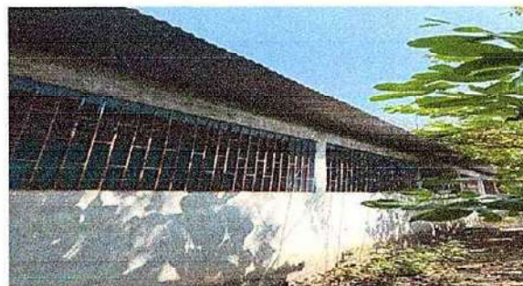
Foto 8: 19 MANO DE OBRA ESPECIALIZADA (ALBAÑILERIA, HERRERIA, ELECTRICIDAD Y PLOMERIA) 19.7 Instalación de estructura portante de metal 19.8 Instalación de lamina troquelada de aluzin calibre 26
