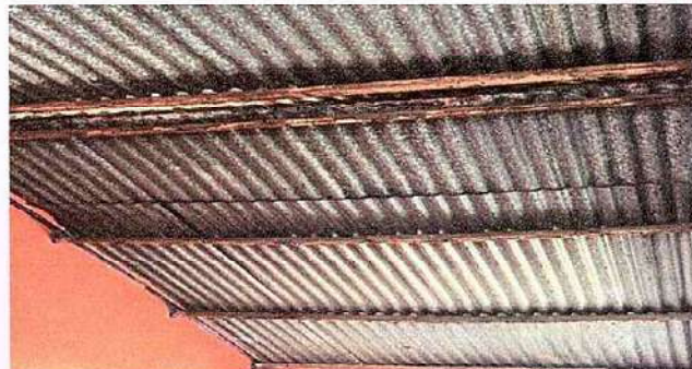
Foto2: 1 CUBIERTA DE LAMINA. 1.1 Sustitución de lámina, por lámina troquelada aluzinc calibre 26" y 2.2 Sustitución de estructura de soporte de madera, por metal.
