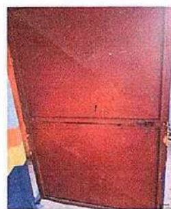
Foto 4: 4 PUERTAS DE METAL: 4.3 Sustitución de puerta
