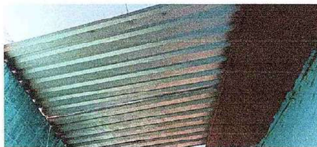
Foto 10: 19 MANO DE OBRA ESPECIALIZADA (ALBAÑILERIA, HERRERIA, ELECTRICIDAD Y PLOMERIA) 19.7 Instalación de estructura portante de metal 19.8 Instalación de lamina troquelada de aluzin calibre 26
