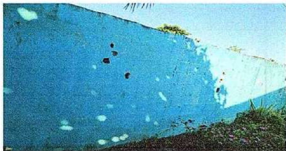
Foto 11: 15 MUROS PERIMETRALES 15.1 Reparación de muro perimetral de bloques
