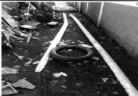
Foto 5: REPARACIÓN DE DRENAJE. Sustrución de tubería PVC línea principal aguas negras.
