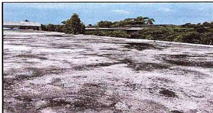
Foto4: 3 IMPERMEABILIZACIÓN DE LOSA. 3.1 Impearmibilización de losa.
