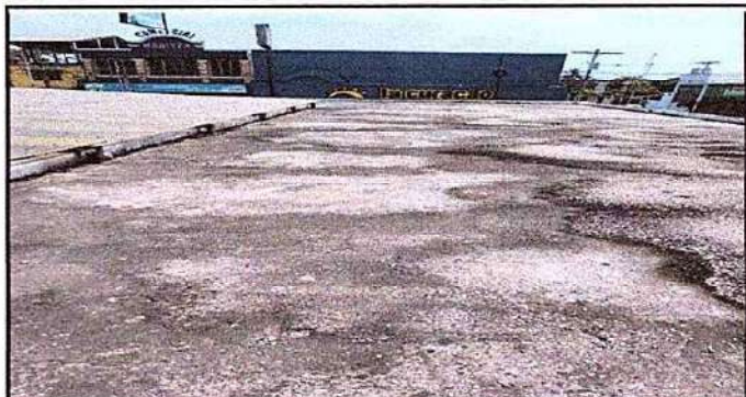
Foto2: 3 IMPERMEABILIZACIÓN DE LOSA. 3.1 Impearmibilización de losa.
