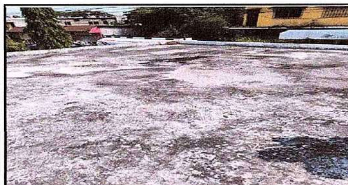
Foto3: 3 IMPERMEABILIZACIÓN DE LOSA. 3.1 Impearmibilización de losa.
