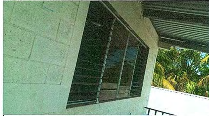
Foto 2: 5.5 Sustitución de vidrios
