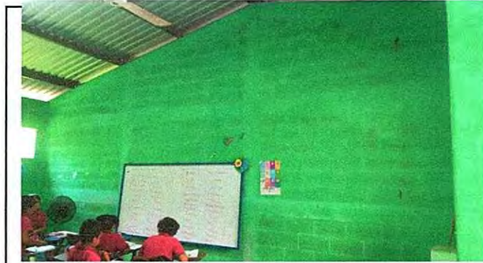
Foto 6: 21.1 Repello en muro
