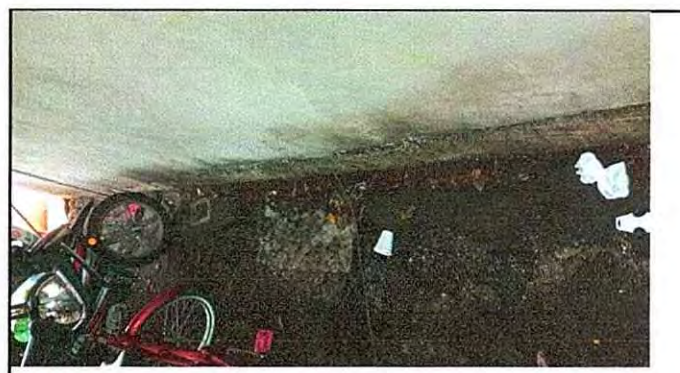
Foto 4: 8.2 repación de banquetas de concreto
