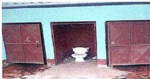
Foto 3: 4.4 Sustitución de puerta en servicio sanitario
