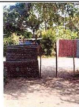
Foto 6: 4.5 Sustitución de portón de metal
