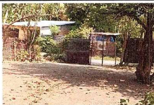
Foto 5: 4.5 Sustitución de portón de metal
