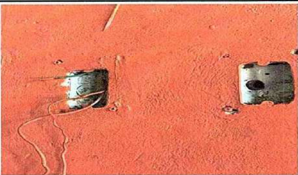
Foto 5: 19.12 instalación de unidades de fuerza (tomacorriente), incluye cable eléctrico.
