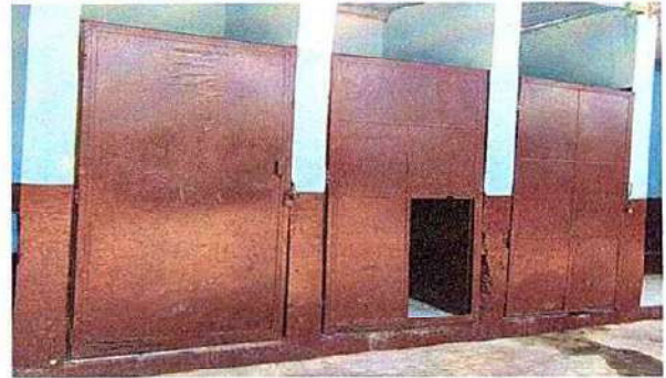
Foto 2: 19.4 Fabricación e instalación de puertas de metal en baños
