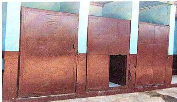
Foto1: 4.4 Sustitución de puerta en servicios sanitarios
