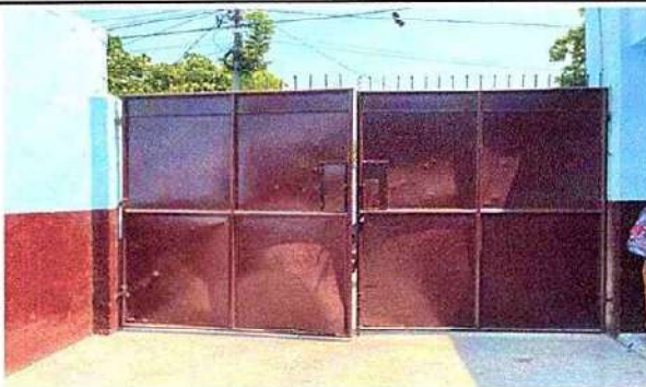
Foto 3: 19.5 Fabricación e instalación de porton de metal de ingreso
