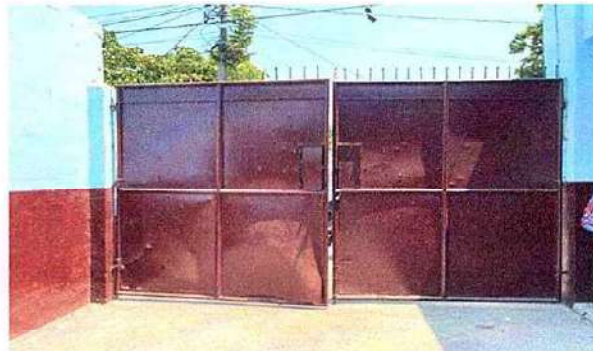
Foto 2: 4.5 Sustitución de portón de metal
