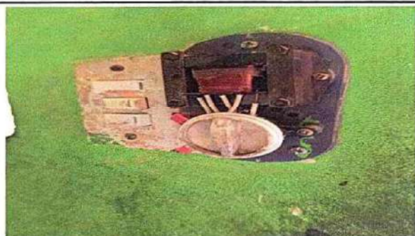
Foto 5: 17.6 Sustitución de interruptores simples
