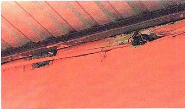
Foto1: 17.12 Sustitución de ducto eléctrico+accesorios
