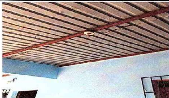
Foto 3: 17.4 Sustitución de focos ahorradores
