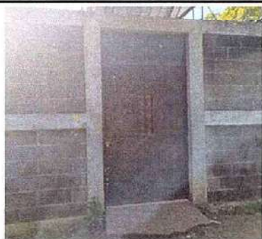
Foto 1. 4.1 Mantenimiento a estructura (lijado, cambio de tubo, cepillado, sujeciones, aplicación de pintura)
