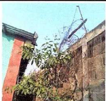
Foto 5. 7.4 Sustitución de bajada de agua pluvial de metal por tubo PVC 3"
