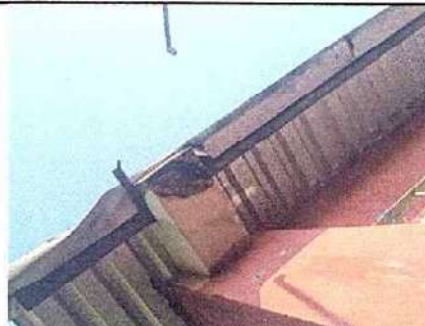
Foto 6. 7.5 Sustitución de soporte o pescante de metal para canal
