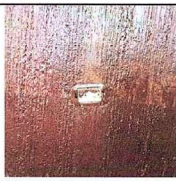
Foto 12. 17.8 Sustitución de tomacorrientes dobles.
