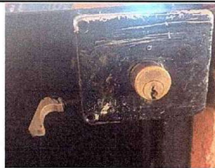
Foto 2. 4.2 Sustitución de Chapa
