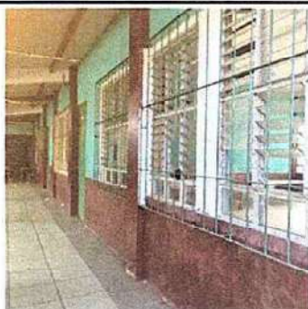
Foto 3. 5.7 Mantenimiento a balcones de metal
