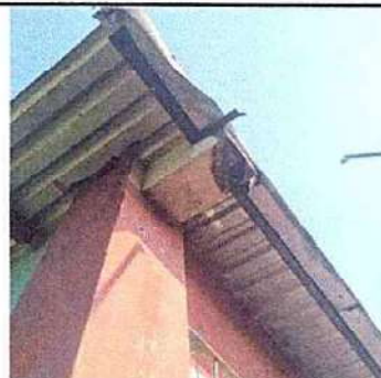
Foto 4. 7.1 Sustitución de canal de metal,
