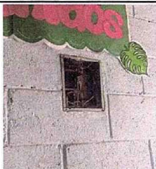
Foto 13. 17.10 Sustitución de filpones
