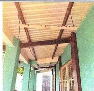
Foto 10. 17.5 Sustitución de plafoneras
