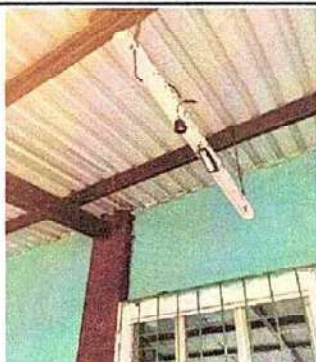
Foto 9. 17.4 Sustitución de focos ahorradores
