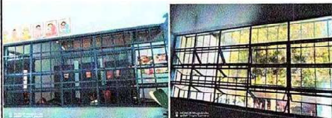
Foto 1: 5.2 Sustitución de estructura de metal de ventana ✓
