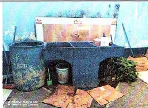
Foto 4: 19.20 Instalación de pila ✓
