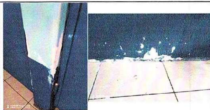
Foto 5: 21.1 Repello en muro
