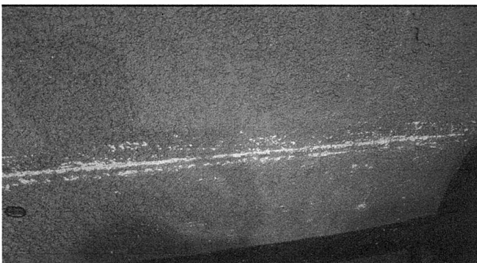
Foto 3: Desde 2015 no se ha pintado el centro educativo, la pintura ya esta demasiado deteriorada, exterior e interior.
