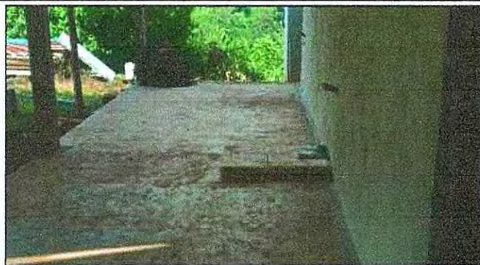
16. 1 Reparación de planchas de concreto de patio
