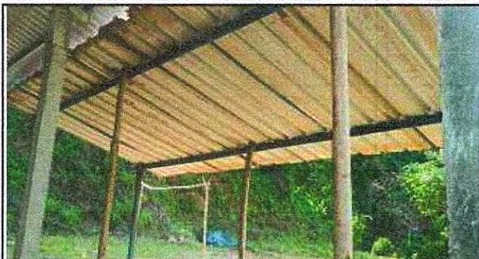
1.1 Sustitución de lámina, por lámina troquelada aluzinc calibre 26. 2.2 Sustitución de estructura de soporte de madera, por metal
