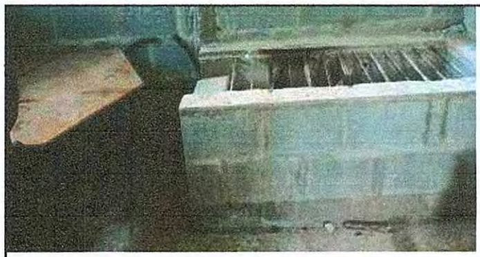
20.1 Mantenimiento a estufa rural, 20.3 Sustitución de plancha de metal de 3 hornillas y 20.5 Sustitución de chimenea de concreto
