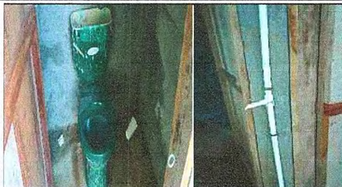
10. 3 Sustitución inodoro, 10.8 Sustitución de Mingitorio y 10. 9 Sustitución de Grifos
