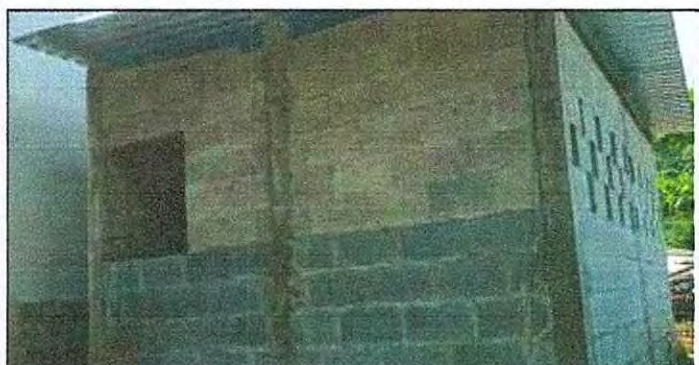
21.1 Repello en Muro y 21.4 Sellado de grietas y fisuras en muro
