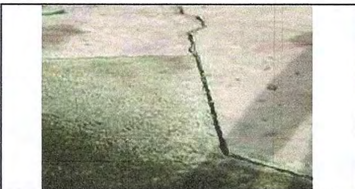
8.2 Reparación de banquetas de concreto
