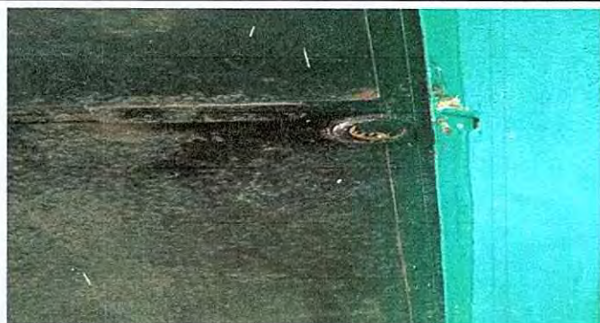
Foto1: 4.2 sustitucion de chapa
