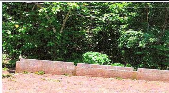
Foto 2: 15.8 seguimiento de muro perimetral de block
