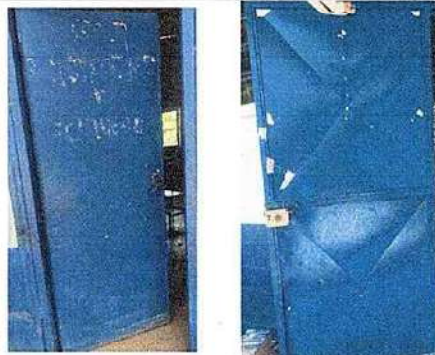
Foto 2: 4.1 Mantenimiento a estructura (lijado, cambio de tubo, cepillado, sujeciones, aplicación de pintura a puertas, 4.2 Sustitución de chapa y 4.3 Sustitución de puerta.
