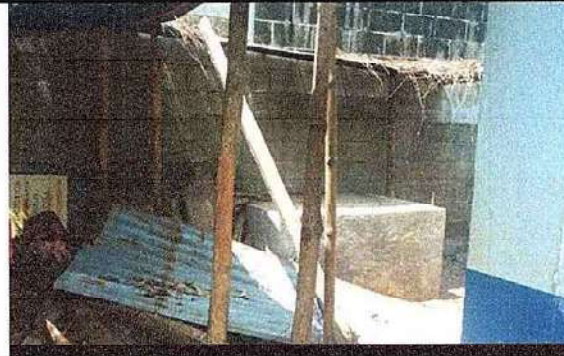
Foto 2: 15.1 Reparación de muro perimetral de block
