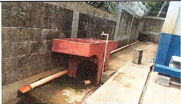
Foto 1: 14.3 Sustitución de tubería PVC línea principal aguas negras, 14.9 Sustitución de tubería línea principal 14.13 y Sustitución de llave de chorro
