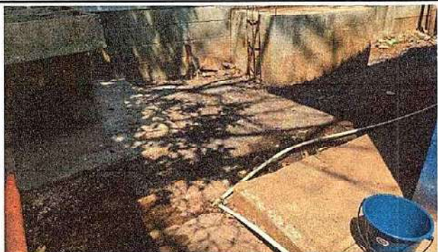
Foto 3: 16.1 Reparación de planchas de concreto de patio
