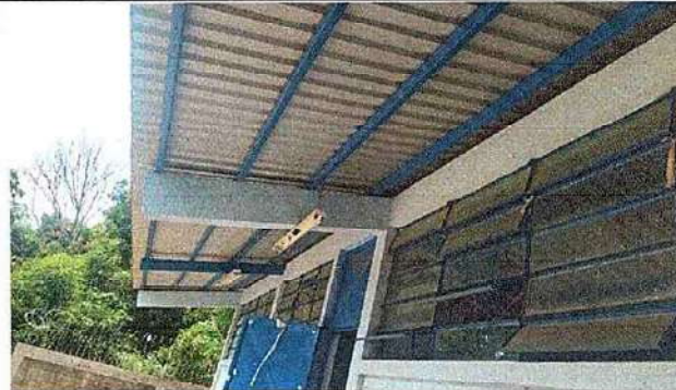
Foto 4: 17.4 Sustitución de focos ahorradores, 17.5 Sustitución de plafoneras, 17.6 Sustitución de interruptores simples, 17.10 Sustitución de filpones, 17.11 Sustitución de cableado eléctrico y 17.12 Sustitución de ducto eléctrico
