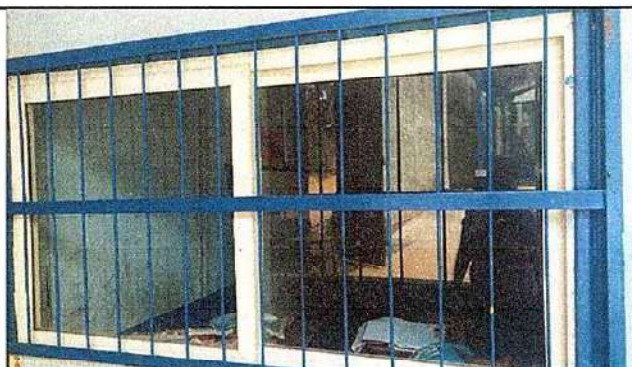
Foto 3: 5.7 Mantenimiento a balcones
