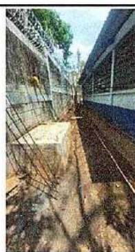
Foto 4: 6.8 Sustitución de piso cerámico
