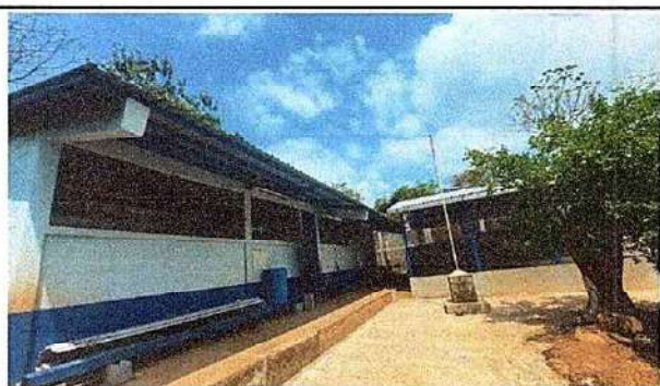
Foto 5: 7.1 Sustitución de canal de metal, 7.4 Sustitución de bajada de agua pluvial de metal por tubo PVC 3" y 7.5 Sustitución de soporte o pescante de metal para canal
