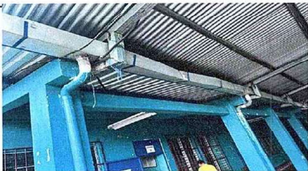
Foto 9:7.1 Sustitución de canal de metal
