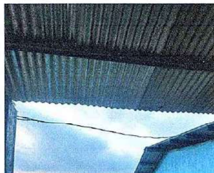
Foto 2: 1.3 Sustitución de elementos de fijación.
