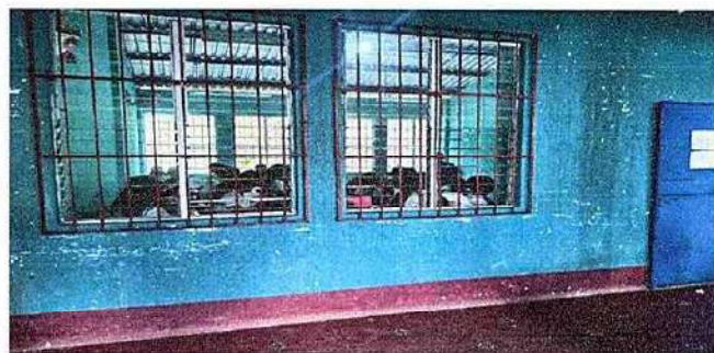
Foto 6: 5.7 Mantenimiento a balcones de metal ✓
