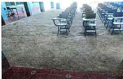
Foto 8: 6.8 Sustitución de piso cerámico
