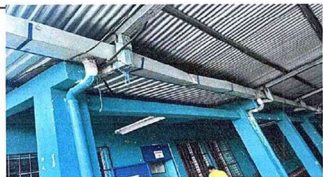
Foto 9:7.1 Sustitución de canal de metal
