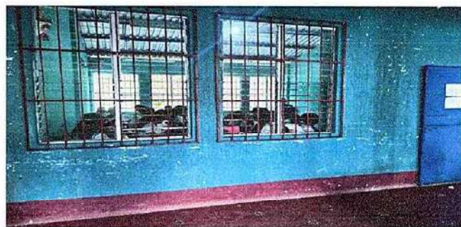
Foto 6: 5.7 Mantenimiento a balcones de metal ✓
