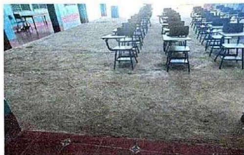
Foto 8: 6.8 Sustitución de piso cerámico
