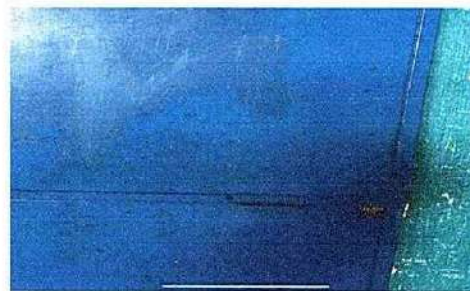
Foto 4: 4.2 Sustitución de chapa ✓
