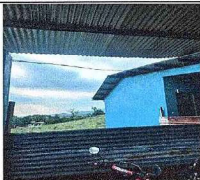
Foto 1: 1.1 Sustitución de lámina, por lámina aluzinc calibre 26 ✓
