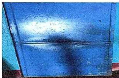
Foto 5: 4.3 Sustitución de puerta ✓
