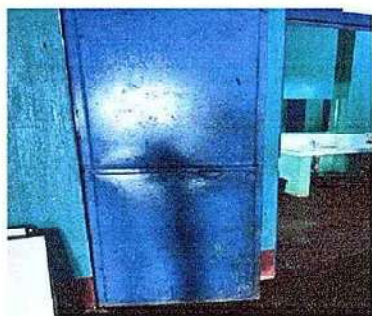
Foto 3: 4.1 Mantenimiento a estructura (lijado, cambio de tubo, cepillado, sujeciones, aplicación de pintura) ✓
