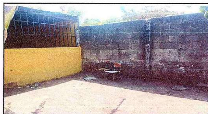
Foto 11: 9.1 PINTURA EN MUROS EXTERIORES E INTERIORES
