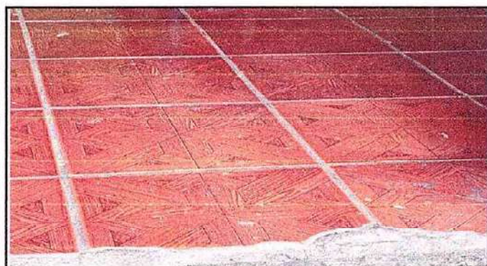
foto 10: 6.8 SUSTITUCIÓN DE PISO CERAMICO CERAMICO
