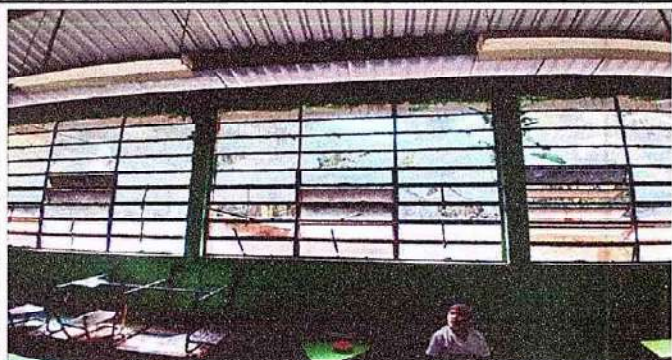
Foto 7: 5.2 SUSTITUCIÓN DE ESTRUCTURA DE METAL DE VENTANA POR (BALCONES DE METAL)
