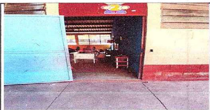
Foto 5: 4.3 SUSTITUCIÓN DE PUERTA
