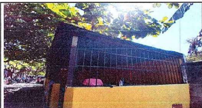
Foto 3: 2.3 SUSTITUCION DE ESTRUCTURA DE SOPORTE DE METAL POR METAL
