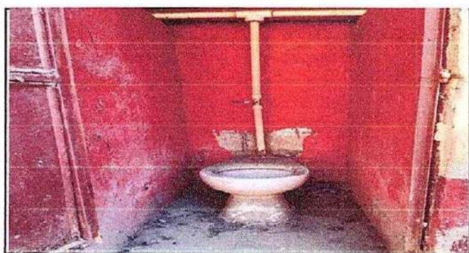
Foto 11: 10.3 SUSTITUCIÓN DE INODOROS
