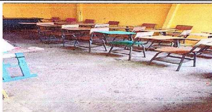
Foto 8: 6.5 SUSTITUCIÓN DE PISO DE TORTA DE CEMENTO POR TORTA
