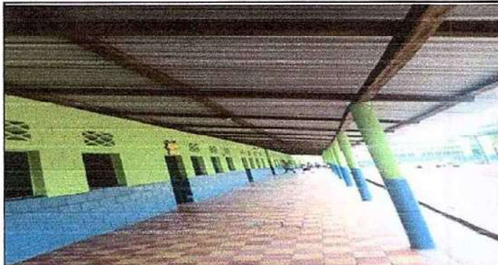
Foto 1: 2.2 SUSTITUCION DE ESTRUCTURA DE SOPORTE DE MADERA, POR METAL
