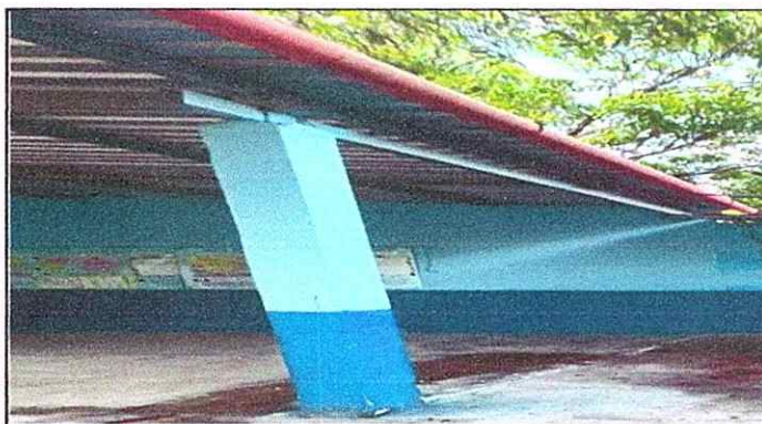
FOTO 4: 7.1 Sustitución de canal de metal
