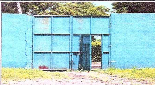
FOTO 7: 12.1 Mantenimiento a porton de metal
