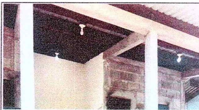
FOTO 10: 17.4 Sustitución de focos ahorradores
