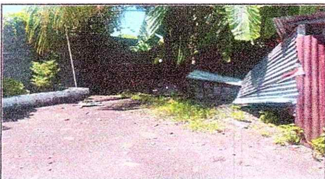
FOTO 9: 15.1 Reparación de muro perimetral de block
