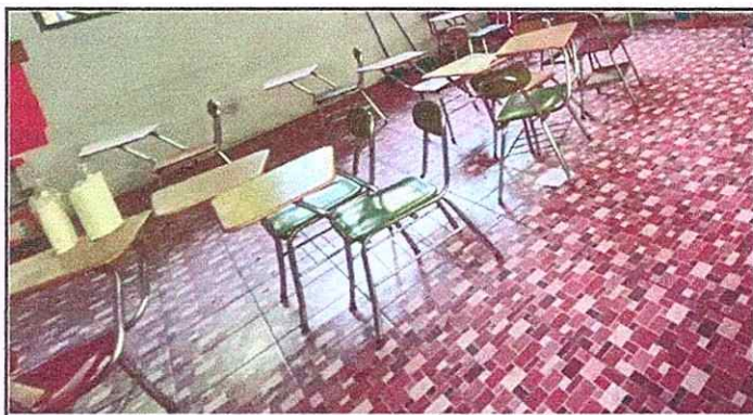
FOTO 3: 6.8 Sustitución de piso ceramico
