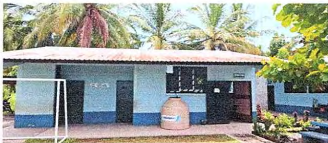
Foto 1: 1.1 Sustitución de lámina, por lámina troquelada aluzinc calibre 26
