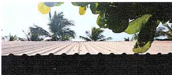
Foto 3: 1.3 Sustitución de elementos de fijación
