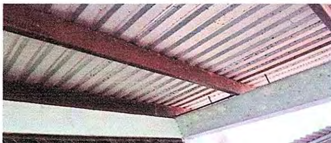
Foto 4: 2.1 Mantenimiento a estructura de soporte de metal
