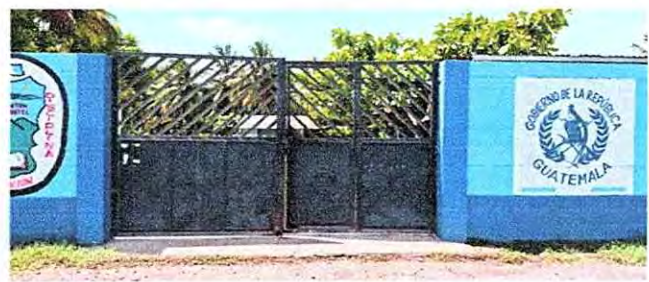
Foto 6: 12.1 Mantenimiento a portones de metal
