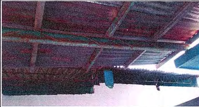
FOTO 1: 1.1 Sustitución de lamina, por lamina troquelada aluzinc calibre 26
