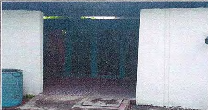
FOTO 3: 4.4 Sustitución de puerta en servicios sanitarios
