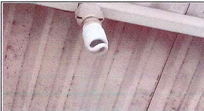
FOTO 8: 17.5 Sustitución de plafonera
