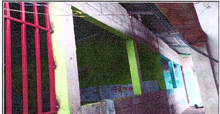
FOTO 4: 5.2 Sustitución de estructura de metal de ventana
