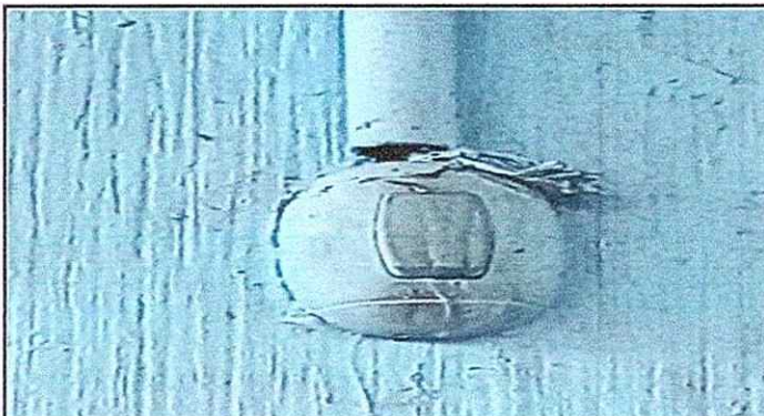
FOTO 9: 17.6 Sustitución interruptores simples
