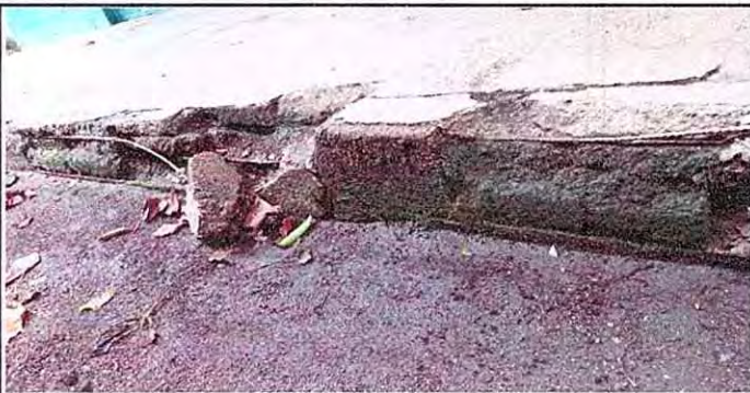
FOTO 5: 8.2 Reparación de banquetas de concreto
