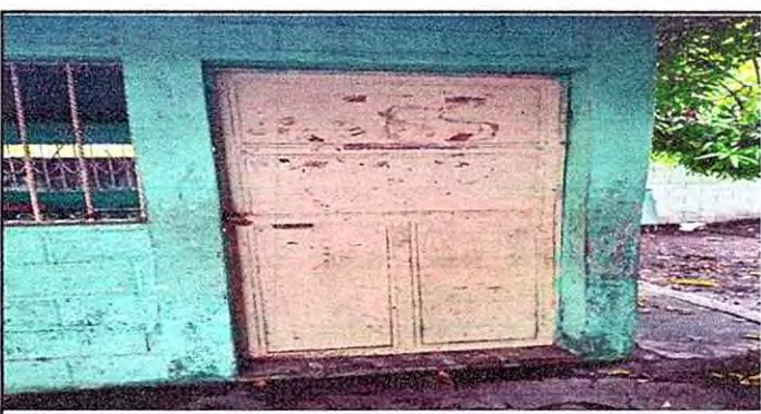
FOTO 6: 4.1 MANTENIMIENTO A ESTRUCTURA (LIJADO, CAMBIO DE TUBO, SUJESIONES, CEPILLADO, APLICACIONES DE PINTURA)
