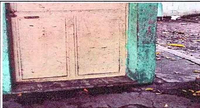
FOTO 7: SUSTITUCION DE CHAPA
