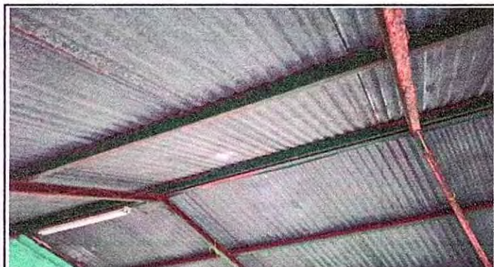
FOTO 3: 2.1 MANTENIMIENTO A ESTRUCTURA DE SOPORTE DE METAL
