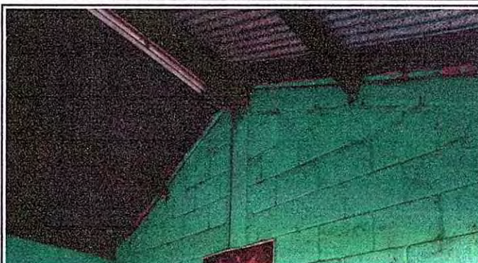
FOTO 2: 1.2 SUSTITUCION DE CAPOTE DE LAMINA PARA LAMINA TROQUELADA
