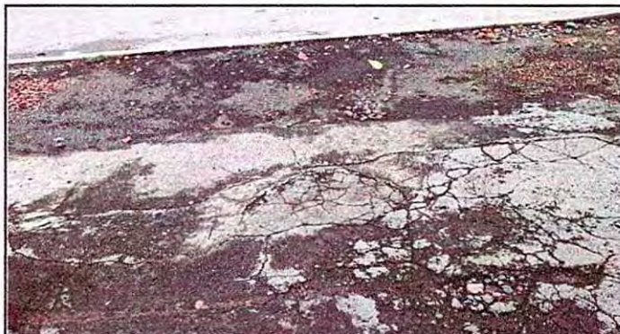
FOTO 9: SUSTITUCIÓN DE PISO DE TORTA DE CONCRETO
