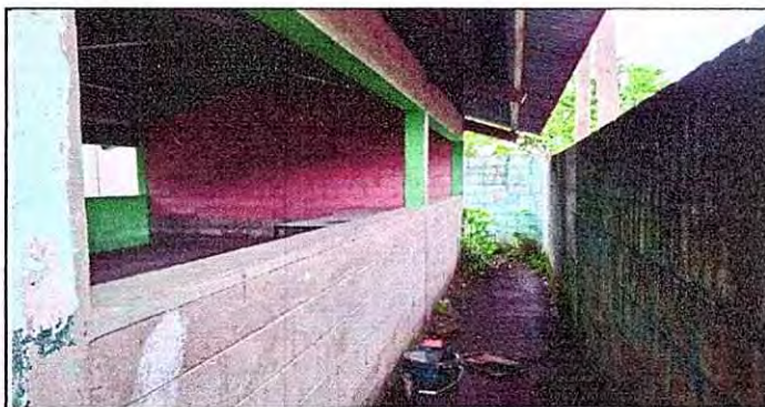
FOTO 12: REPARACIÓN DE MURO PERIMETRAL DE BLOCK
