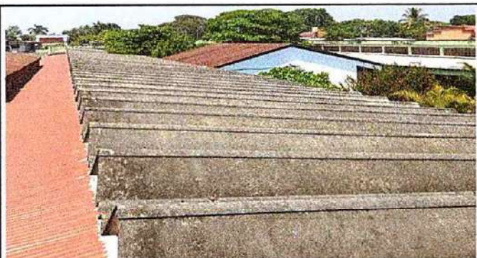
Foto3: 1 CUBIERTA DE LÁMINA 1.1 Sustitución de lámina, por lámina troquelada aluzinc calibre26
