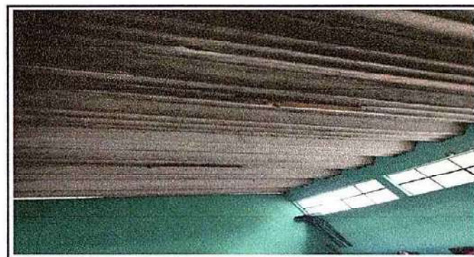
Foto6: 1 CUBIERTA DE LÁMINA 1.3 Sustitución de elementos de fijación
