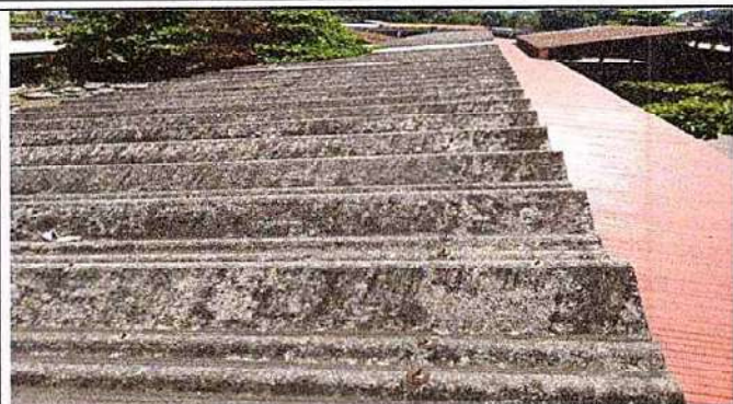
Foto1: 1 CUBIERTA DE LÁMINA 1.1 Sustitución de lámina, por lámina troquelada aluzinc calibre26
