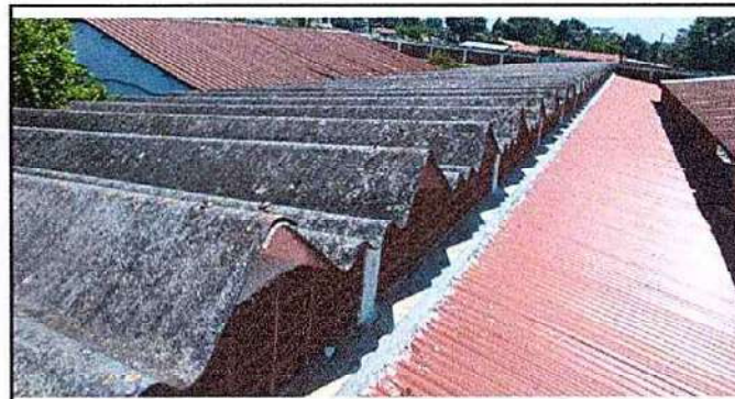
Foto4: 1 CUBIERTA DE LÁMINA 1.3 Sustitución de elementos de fijación
