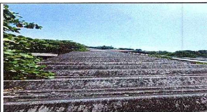
Foto5: 1 CUBIERTA DE LÁMINA 1.3 Sustitución de elementos de fijación
