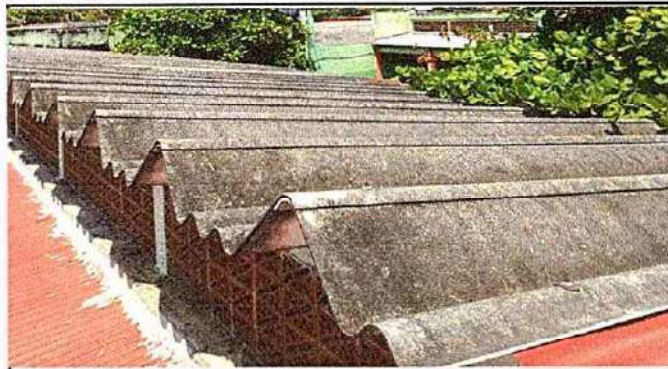
Foto2: 1 CUBIERTA DE LÁMINA 1.1 Sustitución de lámina, por lámina troquelada aluzinc calibre26
