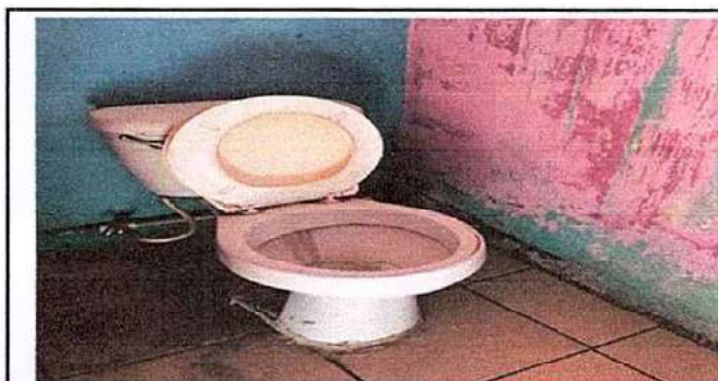
Foto 7: 10. SERVICIOS SANITARIOS Y SUS ACCESORIOS. 10.3. Sustitución de inodoros
