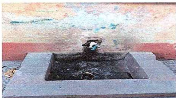
Foto 7: 10. SERVICIOS SANITARIOS Y SUS ACCESORIOS. 10.3. Sustitucion de lavamanos
