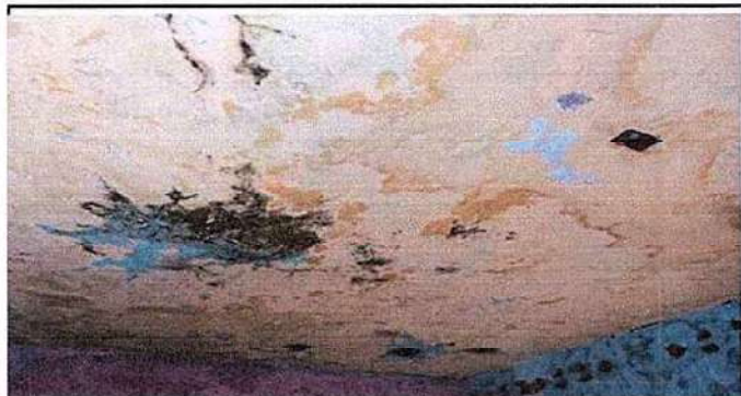
Foto 1: 3. IMPERMEABILIZACION DE LOSA 3.1 impermeabilización de losa 3.2. Reparación de pañuelos.
