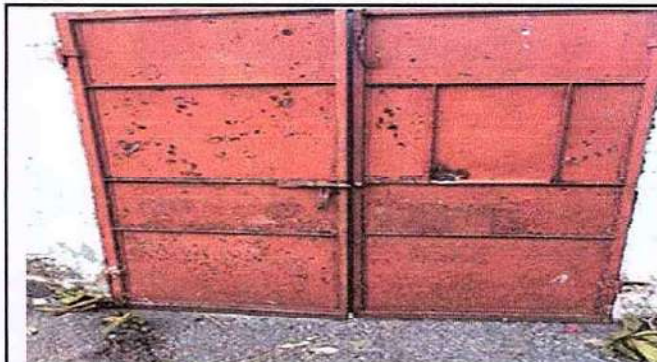
Foto 2: 4 PUERTAS DE METAL. 4.5 SUSTITUCIÓN DE PORTÓN DE METAL 19.5 fabricación e instalación de portón de metal de ingreso 2.40 x 2.50 mts
