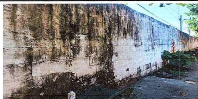
Foto 11: REPARACION DE REPELLO Y CERNIDO DE PAREDES (CUANDO APLIQUE). 21.1 repello en muro en muro perimetral 21.2 cernido de muro perimetral.
