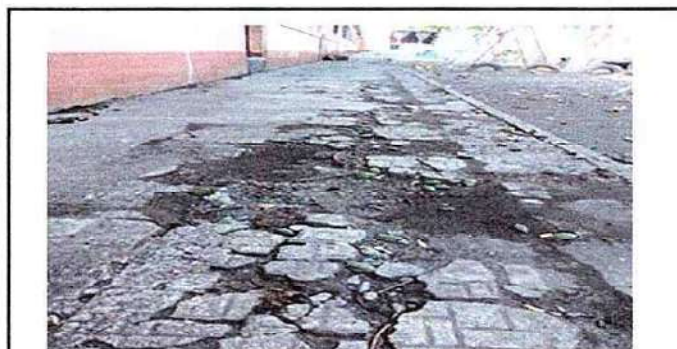
Foto 6: 8. CUNETETA DE CONCRETO 8.2 reparación de banquetas de concreto
