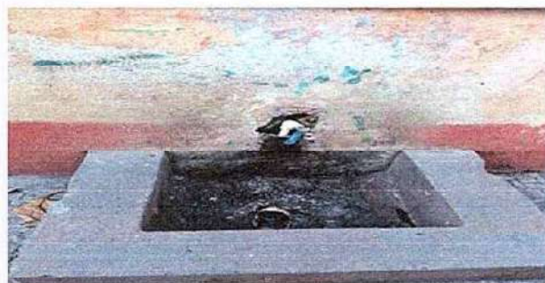
Foto 8: 10. SERVICIOS SANITARIOS Y SUS ACCESORIOS. 10.3. Sustitucion de grifos
