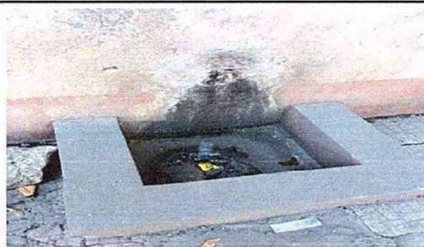
Foto 10: 14. REPARACION DE RED DE DRENAJES Y RED DE AGUA POTABLE. 14.3 sustitución de tubería pvc línea principal aguas negras
