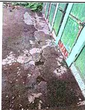
Foto 3: 6. PISO 6.1 Reparación de piso de torta de concreto
