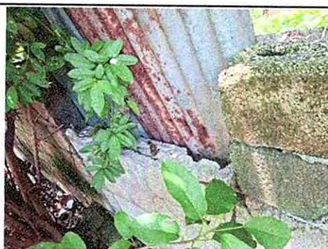
Foto 5: 15. MUROS PERIMETRALES 15.1 Reparación de muro perimetral de block.
