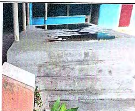
Foto 4: 6. PISO 6.10 Sustitución de torta de concreto, por piso cerámico
