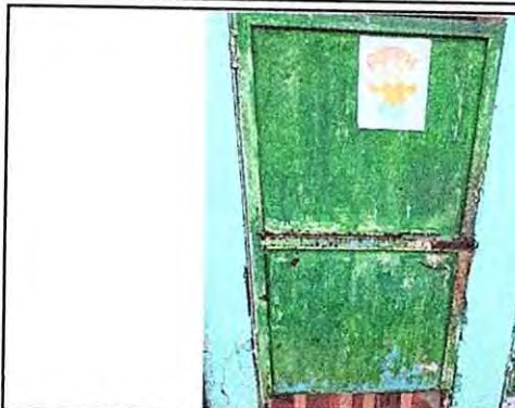
Foto2: 4. PUERTAS DE METAL 4.9 Sustitución de puerta en servicios sanitarios de metal, por puerta de pvc
