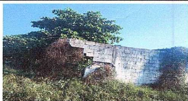
Foto 5: 15 MUROS PERIMETRALES 15.1 REPARACION DE MURO PERIMETRAL DE BLOCK
