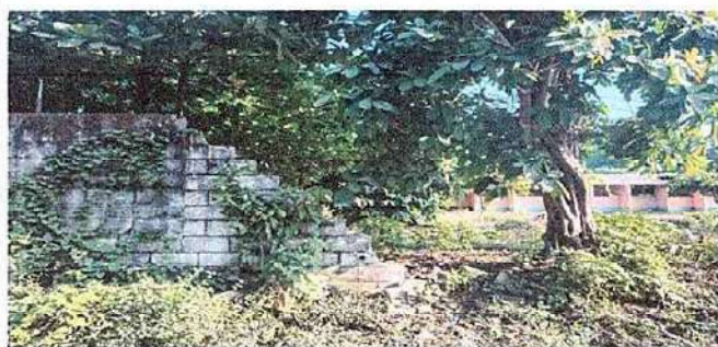
Foto 3: 15 MUROS PERIMETRALES 15.1 REPARACION DE MURO PERIMETRAL DE BLOCK
