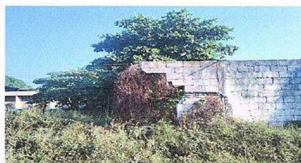
Foto 2: 15 MUROS PERIMETRALES 15.1 REPARACION DE MURO PERIMETRAL DE BLOCK
