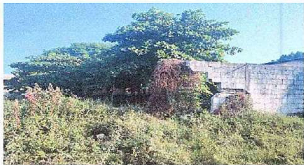
Foto1: 15 MUROS PERIMETRALES 15.1 REPARACION DE MURO PERIMETRAL DE BLOCK
