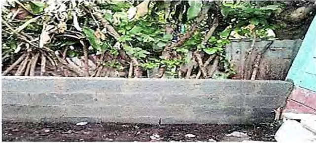
Foto 7: 15 MUROS PERIMETRALES 15.1 Reparación de muro perimetral de block
