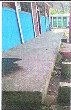
Foto1: 6. PISO 6.10 SUSTITUCIÓN DE PISO DE TORTA DE CONCRETO, POR CERÁMICO
