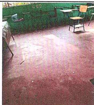
Foto2: 6. PISO 6.11 SUSTITUCIÓN DE PISO DE CEMENTO LIQUIDO, POR CERÁMICO
