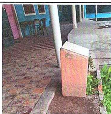
Foto4: 6. PISO 6.11 SUSTITUCIÓN DE PISO DE CEMENTO LIQUIDO, POR CERÁMICO
