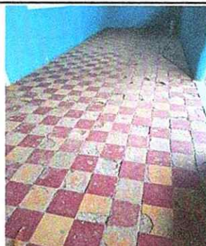
Foto6: 6. PISO 6.11 SUSTITUCIÓN DE PISO DE CEMENTO LIQUIDO, POR CERÁMICO
